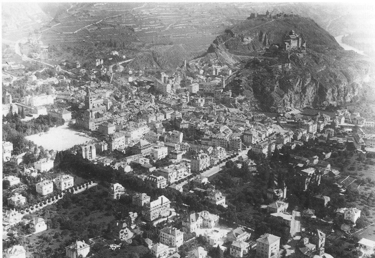
Fig. 42 Vue aérienne de Sion depuis le sud-ouest en 1925. En face de l'avenue du Midi, sur l'avenue de la Gare, la villa Solioz et la clinique Germanier.
