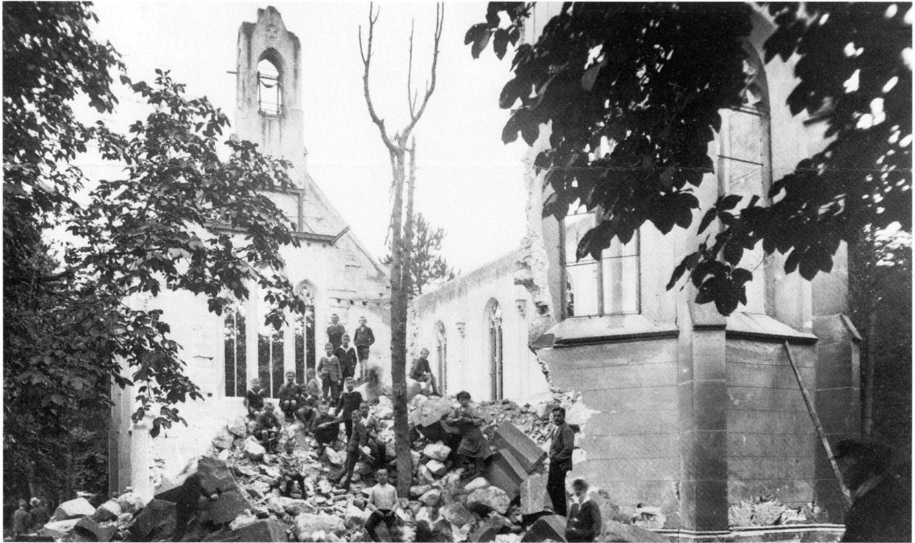
Abb. 9 Die erste Reformierte Kirche von Ferdinand Stadler während des Abbruchs, 1925. Postkarte.
