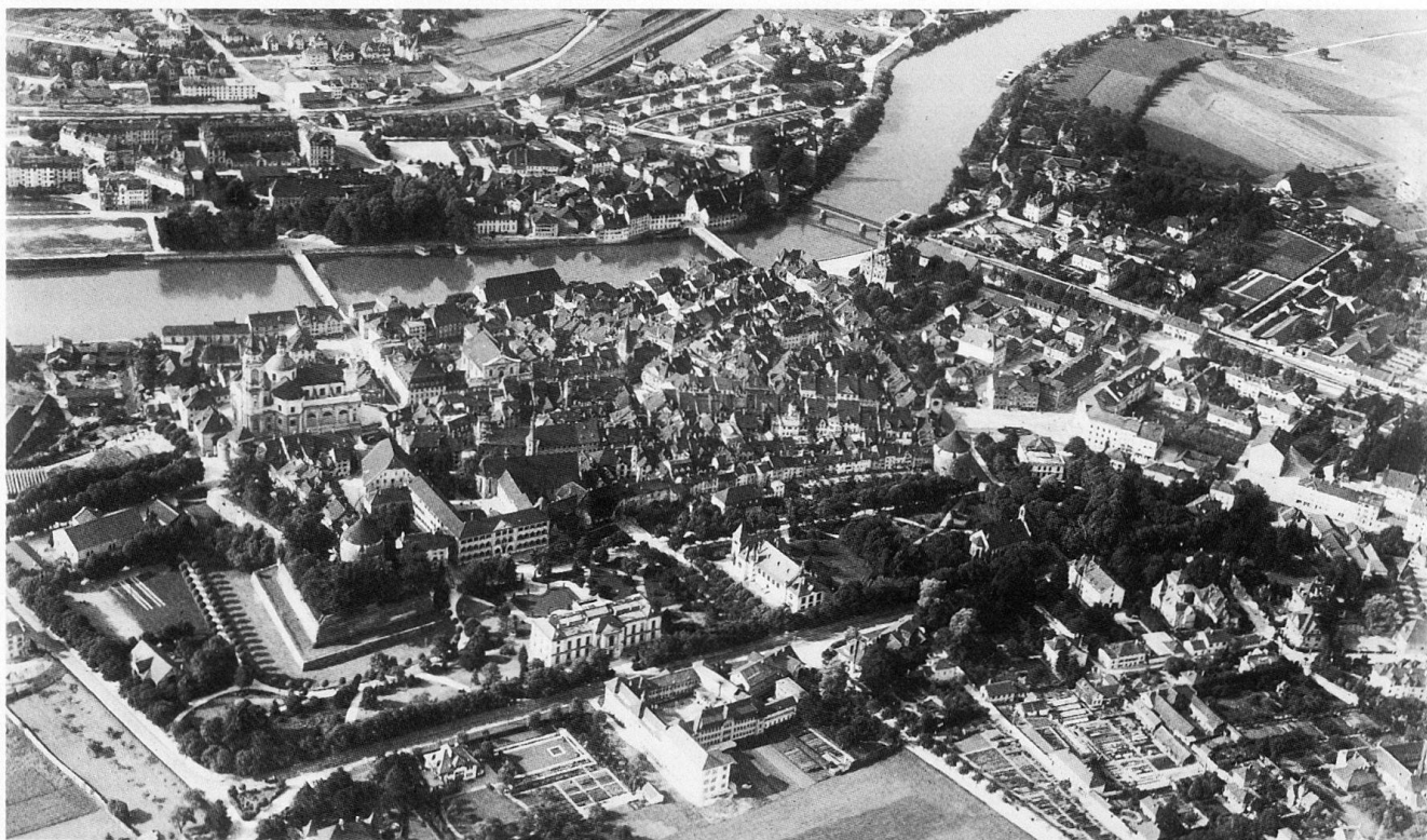
Abb. 40 Blick auf Solothurn von Nordosten. Der Stadtpark erstreckt sich von der Riedholzschanze über das Museum und den Gemeinde- und Konzertsaal bis zur Reformierten Kirche. Flugaufnahme, ca. 1922.
