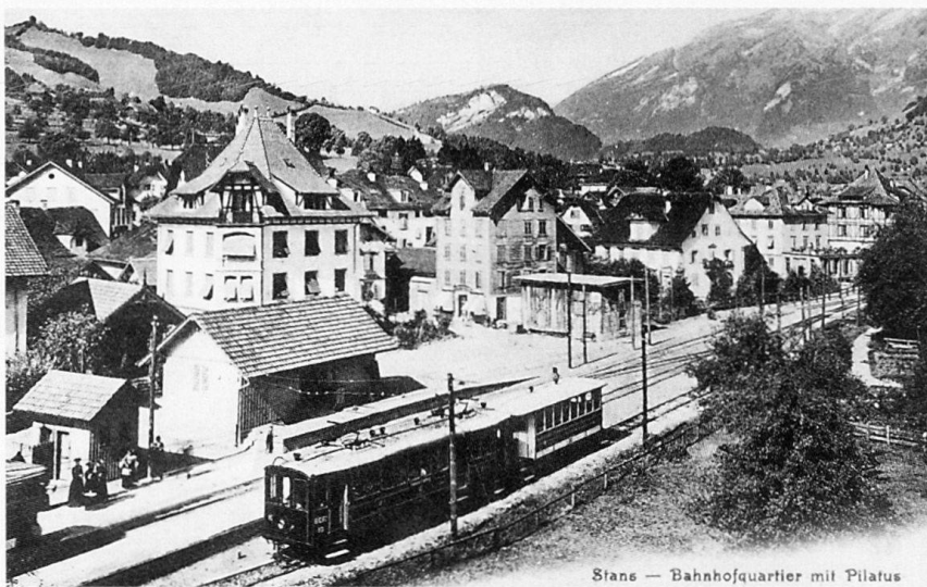
Stans — Bahnhofquartier mit Pilatus
