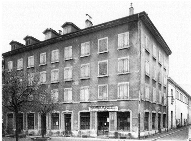
Fig. 43 La maison de la Société philanthropique immobilière édifée en 1870 à la rue du Conseil. Etat peu avant sa démolition en 1989.
