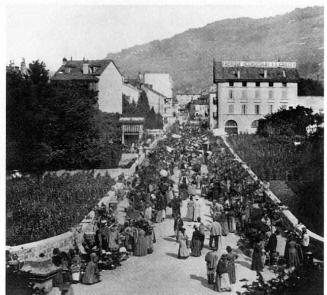
Fig. 18 La nouvelle rue de la Gare accueille en 1889 le marché, déplacé de la Grande Place en raison de la Fête des Vignerons.
