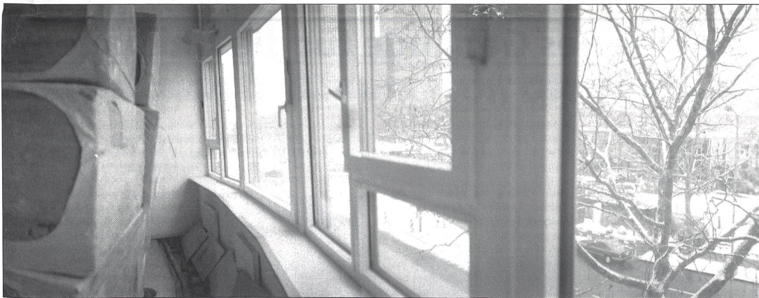
Schöne Aussichten, aber zuwenig Zeit zum Pendeln für die Studierenden am Rande der Stadt: Umbauarbeiten an der Binzmühlestrasse 14.
