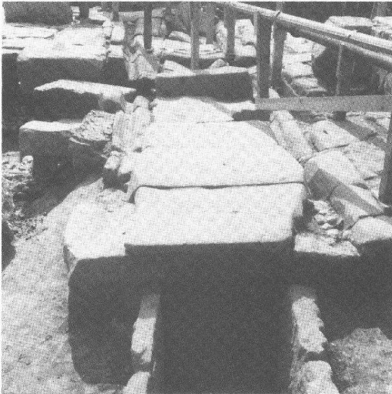
Abb. 36 Kaiseraugst, Parz. 1+3. Westtor. Detailaufnahme von Osten. Abwasserkanal mit Deckplatten und Karrengeleisen.
