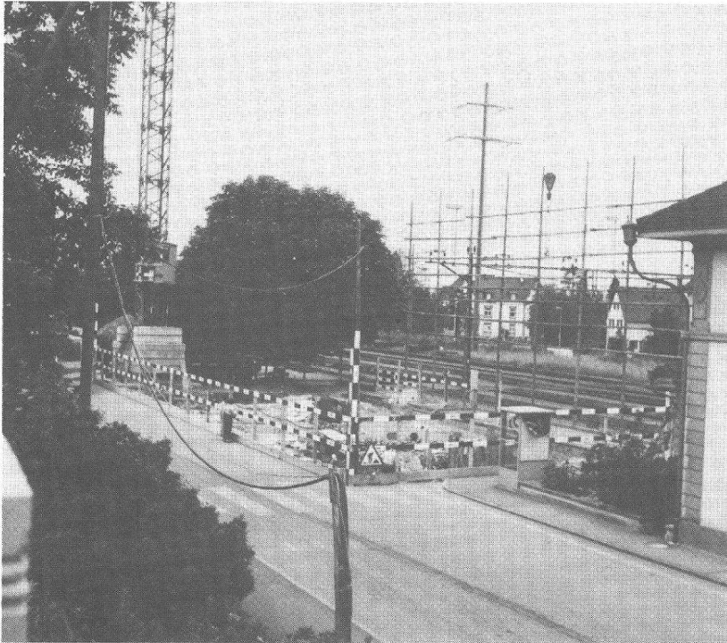
Abb. 38 Kaiseraugst, SBB-Nebengebäude, Parz. 131. Übersicht von Südosten mit Bahnhofstrasse im Vordergrund und Bahngelise des Bahnhofes von Kaiseraugst im Hintergrund.
