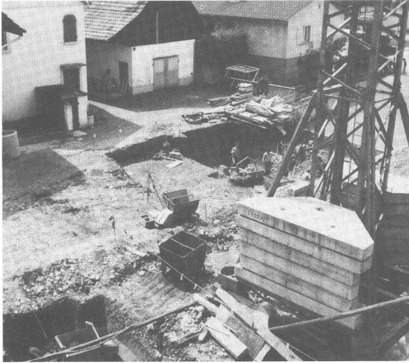
Abb. 26 Pratteln, Katholisches Pfarreizentrum «Romana», Parz. 2055. Übersicht von Nordosten auf die Ausgrabungsfläche.
