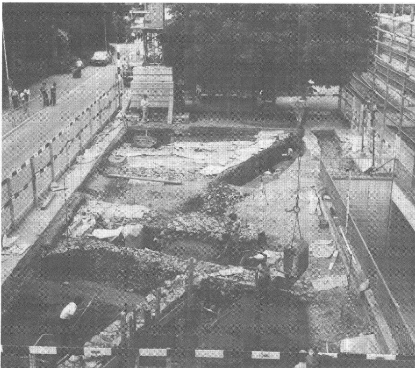
Abb. 39 Kaiseraugst, SBB-Nebengebäude, Parz. 131. Übersicht von Osten mit den Überresten der Häuserreihe östlich der nach Nordosten führenden Strasse.
