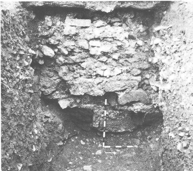
Abb. 53 Kaiseraugst, Parz. 91/92, A. Lüscher. Entsprechender Mauerabschnitt (Abb. 52) von aussen. Fundament aus Spolien und Mauerkern erhalten; die Verblendung fehlt. Ansicht von Osten.
