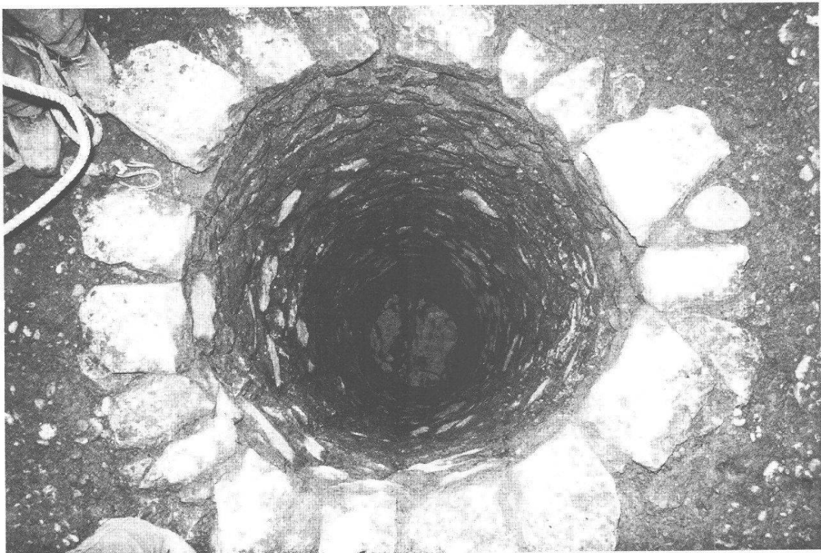
Abb. 40 Kaiseraugst, Parz. 231, Auf der Wacht II. Detail des südlichen Brunnens (Abb. 39) mit dem Felsen als Sohlenabschluss.
