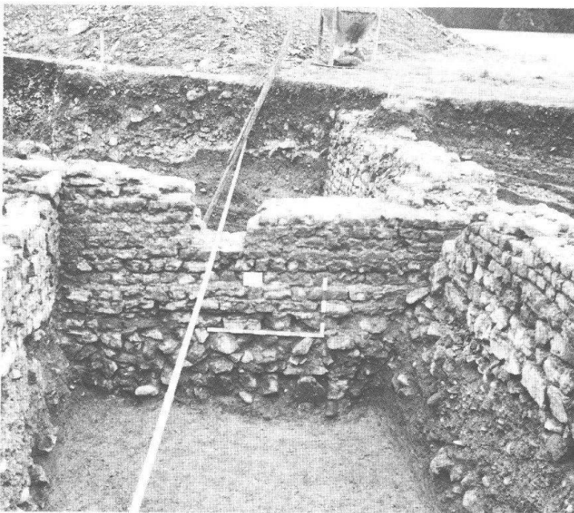
Abb. 32 Augst, Parz. 435, Giebenacherstrasse/FT.S.-Projekt, Ins. I, II, V, VI. Insula 2, die ursprüngliche Hausmauer an der Westfront mit dem Ausbruch für die moderne Wasserleitung. Seitlich im Bild die Mauern des viel weniger tief fundamentierten Anbaues (Abb. 30 und 31). Ansicht von Westen.
