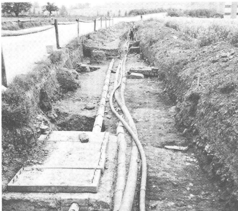
Abb. 1 Augst, Parz. 106.2/20.8, Giebenacherstrasse, Ins. XXXVI. Übersicht über den Sondierschnitt mit modernen Leitungskabeln und quer dazu verlaufenden Mauerzügen. Ansicht von Nordwesten.
