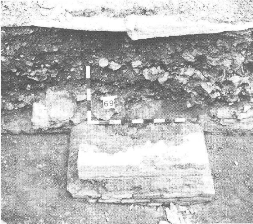
Abb. 10 Augst, Parz. 523/237/1004, Basilicastützmauer, Ins. XIII. Detail (Abb. 9) eines Stützpfeilers an der Südfront des Hauptforums, mit einer deutlich sich abzeichnenden Fase. Ansicht von Südosten.
