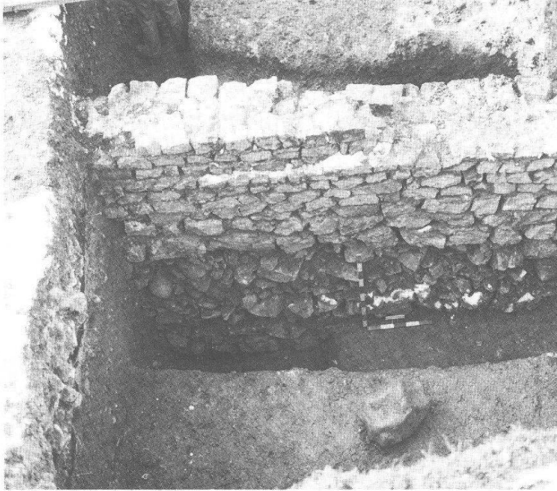
Abb. 16 Augst, Parz. 212, P. Brunner. Hausausschnitt mit MR 1; tiefes Fundament aus Kieselbollen und Kalkbruchsteinen ohne Mörtel, darüber 6 Reihen mit Mörtel gemauertes Vorfundament und 3 Reihen aufgehendes Mauerwerk. Ansicht von Osten.
