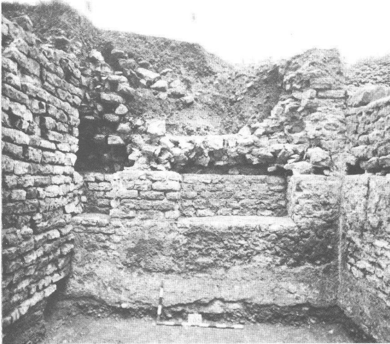
Abb. 6 Augst, Insula 6, Parz. 435/228, Giebenacherstrasse 9. Haus A, Nordmauer MR 11 des Kellers mit den beiden Nischen und den Hohlräumen für die Sturzbalken. In der unteren Zone haftender Wandverputz an MR 9 und MR 11. Ansicht von Süden.
