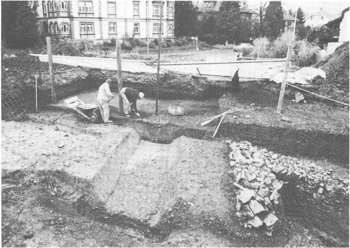
Abb. 18 Kaiseraugst, Parz. 105, Neubau PTT. Vorne rechts: spitzwinklig aneinanderstossende Kalksteinfundamente. Mitte: ausgehobener Graben, der im Profil dahinter als Füllung erkennbar ist. Übersicht von SO.
