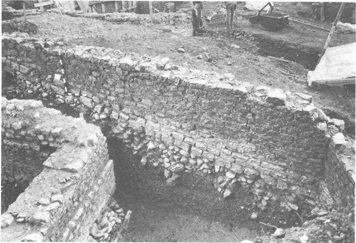
Abb. 3 Kaiseraugst, Parz. 255/257, Schmidmatt, Aufsicht auf die gestuften Mauerzüge des Hauses West. Im Mittelgrund Abwicklung der Haus-Trennmauer mit fallendem Vorfundament über kegelförmigen Fundamentschüttungen, dahinter L-förmige Zufahrtsrampe. Ansicht von SSW.
