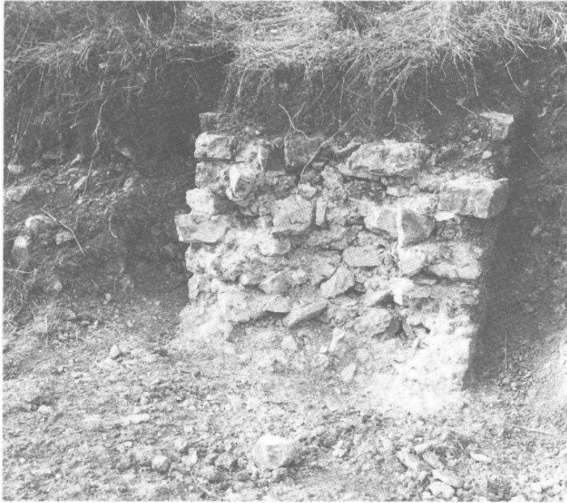
Abb. 7 Augst, Forststrasse im Violenried, Parz. 1008, Insula 33(?). Östlich der Insula 33 der angeschnittene nord-süd-orientierte Mauerzug mit mehr als acht erhaltenen Steinlagen, die bis in die Humusdecke, 10 cm unter die gegenwärtige Oberfläche, reichen. Ansicht von Südosten.
