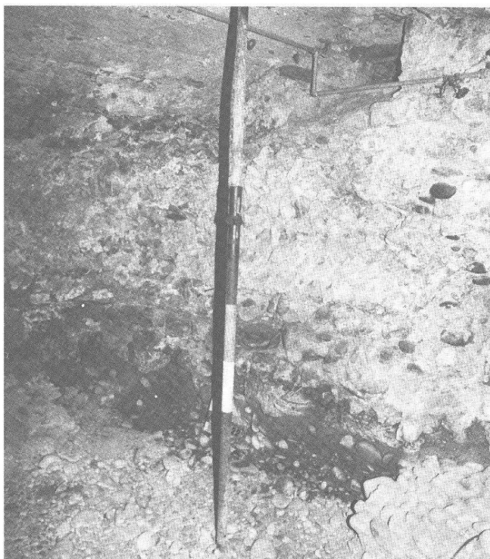
Abb. 37 Kaiseraugst, Dorfstrasse, Parz. 92. Turm 10, Nordwand des Kellers. Über dem gewachsenen Boden bilden schräg gesetzte Kieselbollen die Unterlage für das Turmfundament, in dem Spolien vermauert wurden. Darüber folgen mit Kieselbollen vermischte Kalkbruchsteinlagen. Ansicht von Südosten.
