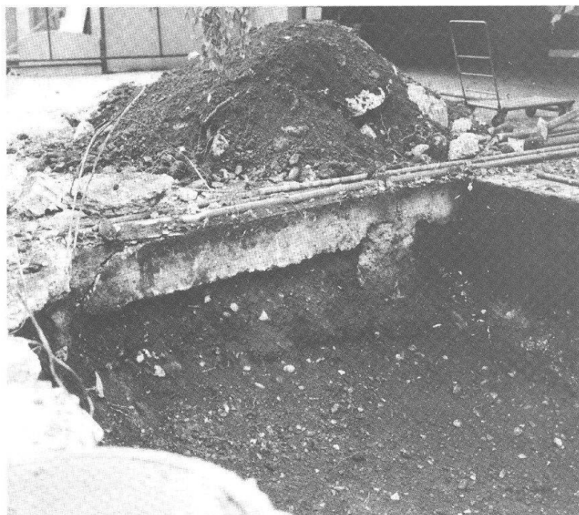
Abb. 28 Augst, Restaurant Rheinlust, Parz. 423. Überblick von Nordosten auf die Grabungsfläche; im Vordergrund modernes Mauerwerk aus Beton.
