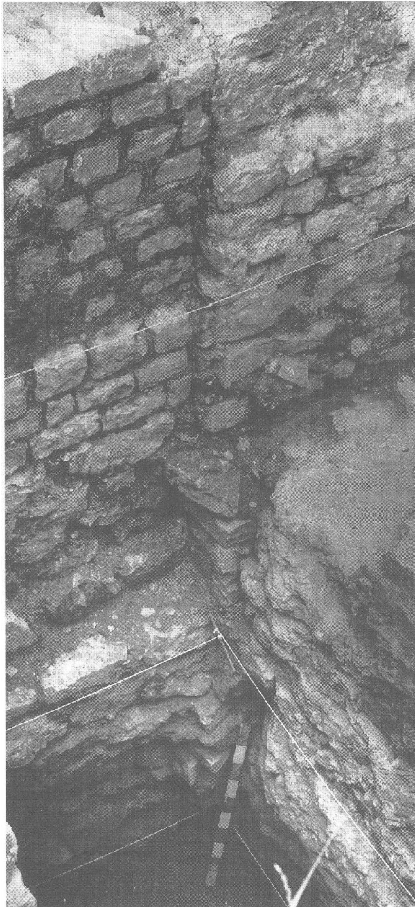
Abb. 9 Augst-Forum. Verstärkte Fundamentpartie am Nordende von MR 4 (links, Bildmitte); rechts davon schliesst MR 9 an; Blick nach Westen.
