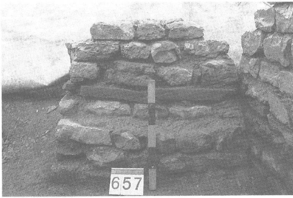
Abb. 36 Periode 3, Bauzustand 7: MR 11, Nordansicht.
