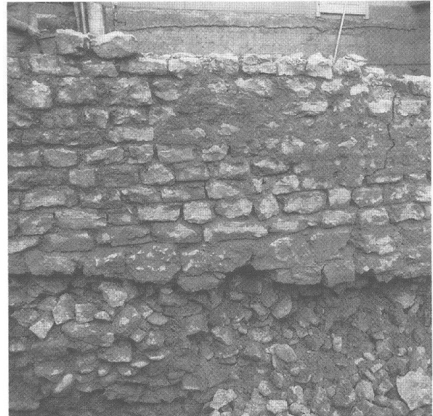
Abb. 31 Periode 3, Bauzustand 7: MR 4, Nordansicht.
