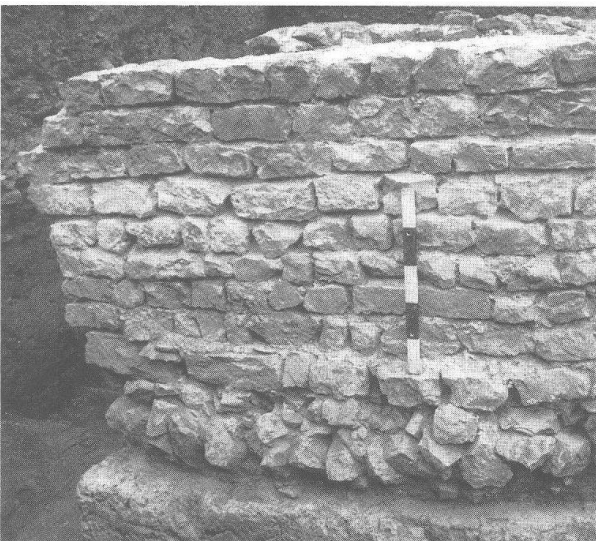
Abb. 39 Periode 3, Bauzustand 8: MR 14 ohne Verputz, Ansicht von Süden.
