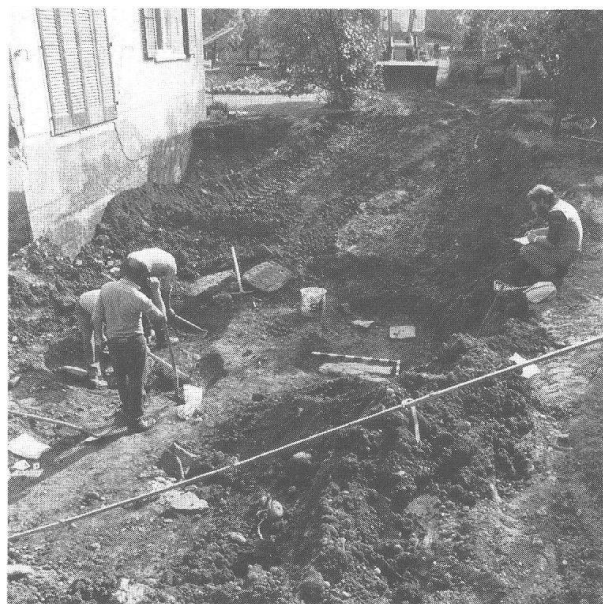
Abb. 12 Kaiseraugst – Gstalteinrain/A. Bolinger (10). Übersicht von SW auf die Baugrube.
