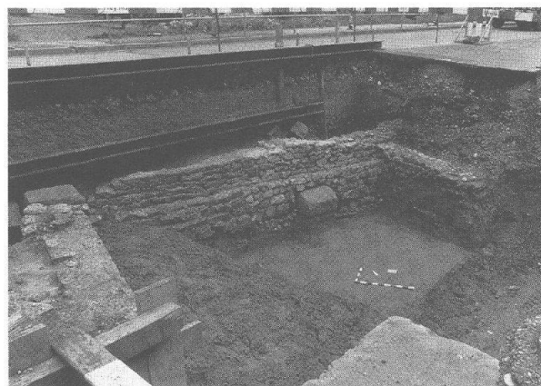
Abb. 22 Kaiseraugst – Landstrasse/Personenunterführung K 292 (2). Mittelteil, links: Gebäudeaussermauer MR 3; Mitte: Parzellengrenzmauer MR 13 rittlings über Sandsteinquader einer frühen Phase; rechts: MR 8. Übersicht von SSW.
