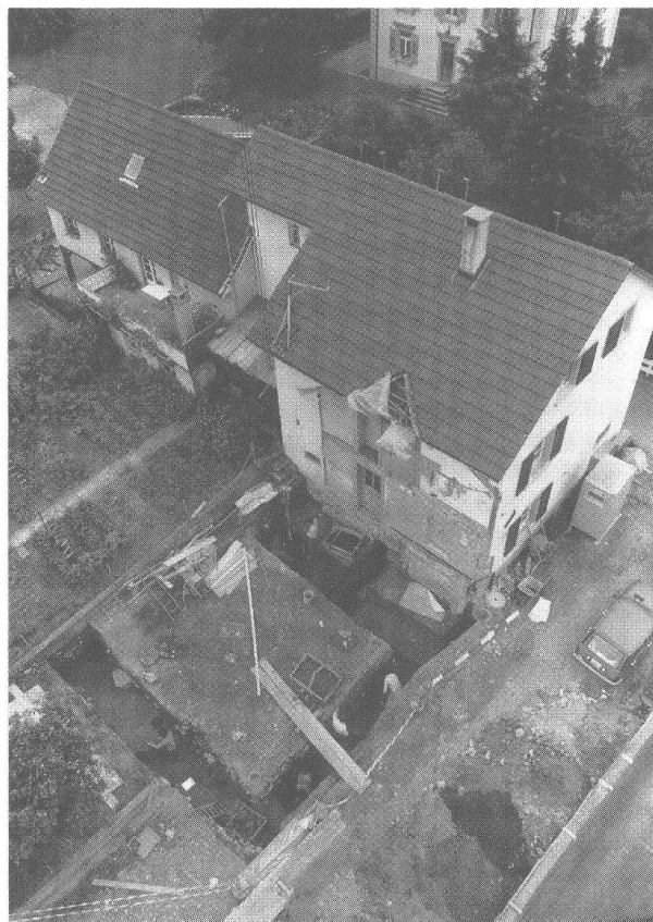
Abb. 27 Kaiseraugst – Heidemurweg/Tellenbach-Delfosse (3). Übersicht von NW auf Grabungssüdteil. Vorne links: W-E-Sondierschnitt, vorne rechts: N-S-Sondierschnitt.
