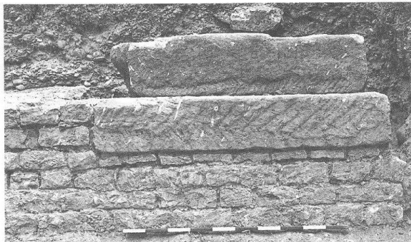
Abb. 44 Augst-Amphitheater 1988. Östlicher Abschluss der Hangstützmauer MR13 mit Sandsteinstufen. Blick von Süden.
