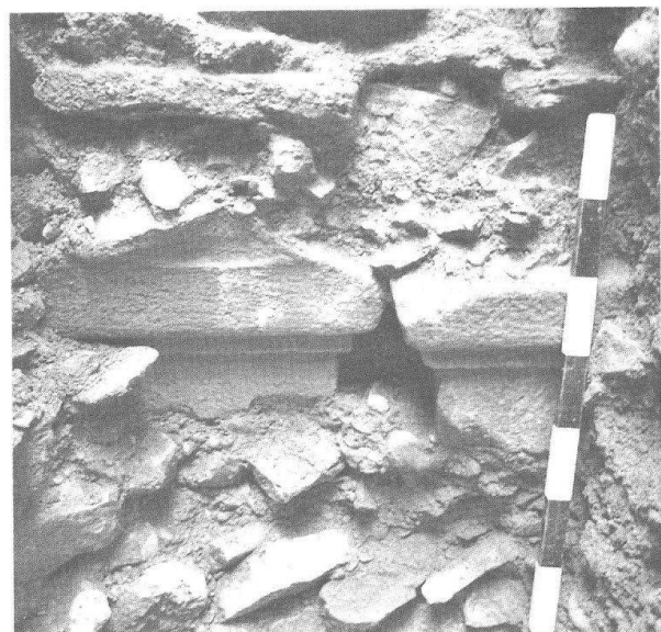
Abb. 35 Kaiseraugst – Heidemurweg/Schopf E. Vogel (13). Architrav (Abb. 32,2).
