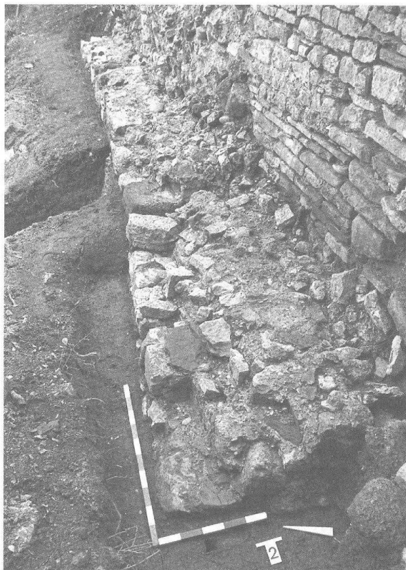
Abb. 16 Kaiseraugst – Rheinuferweg/Kirchengartenstützmauer (06). Aufsicht auf die neuzeitliche Unterfangungsmauer von W.
