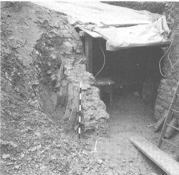
Abb. 17 Augst BL, Grabung 1965–1967.52 (Abb. 2,15). Überrest der in Phase III vom Graben 3 durchschlagenen (Treppen-)Hausmauer der Taberne (Abb. 25, MR 11). Blick nach Süden.
