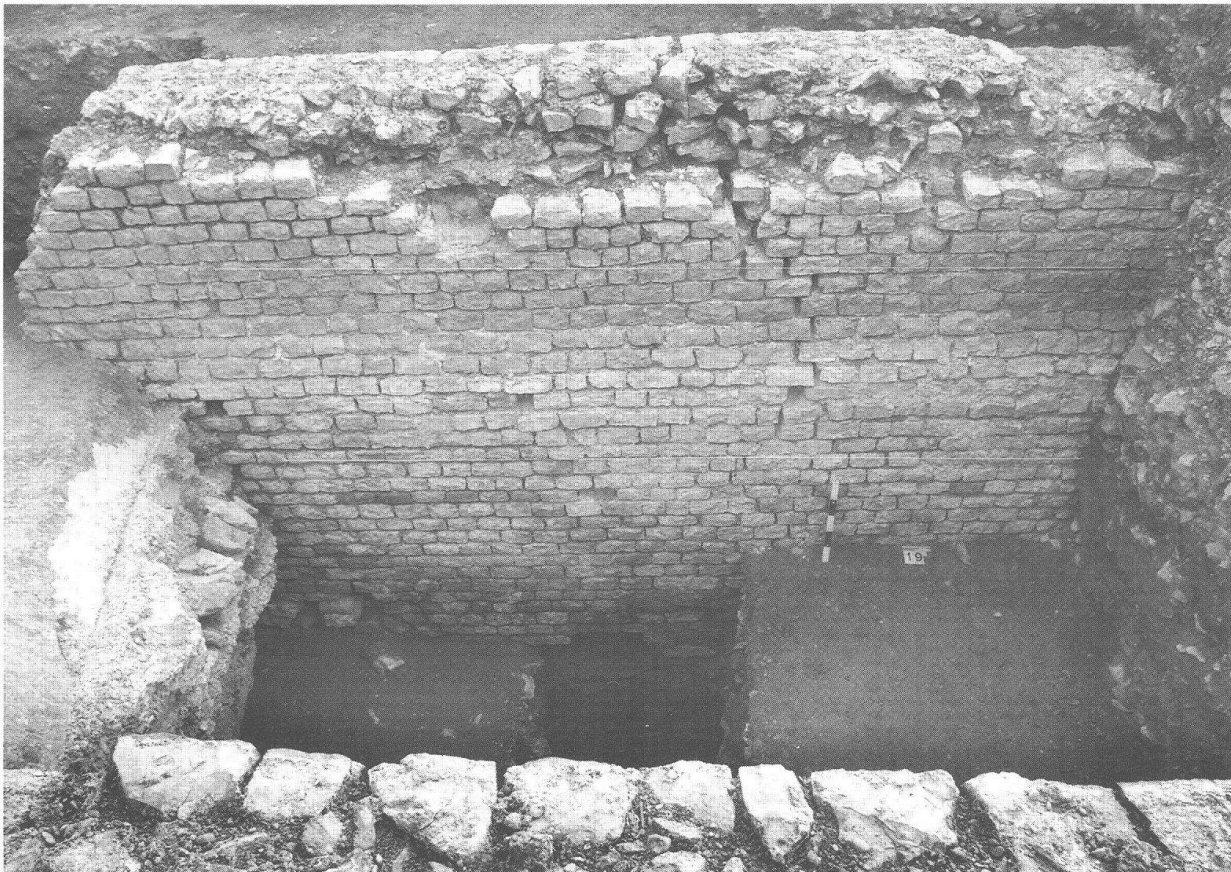
Abb. 9 Augst-Zentralthermen. Blick gegen NO an die Innenseite der (Porticus-)Aussenmuer. Grabung 1989.54.
