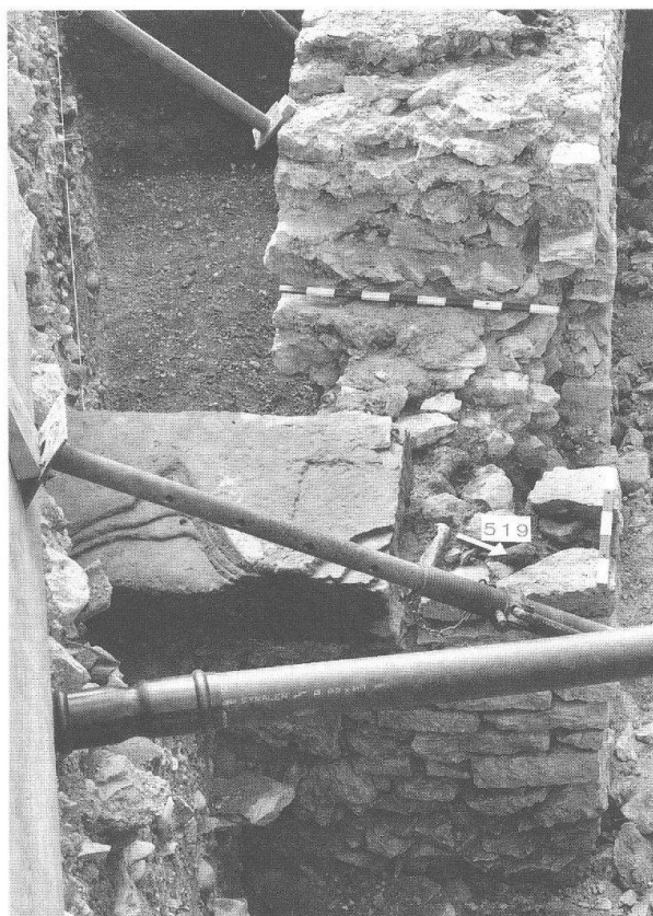
Abb. 22 Augst BL, Nordwestfront Frauenthermen, Grabung 1990.51. Ansicht von Osten an den Eckverband von Mauer 1 (hinten) und 2 nach dem Abtragen der zum 2. Bauzustand gehörenden Mauerteile. In der Bildmitte die «Sandsteinplatte» des 1. Bauzustandes.
