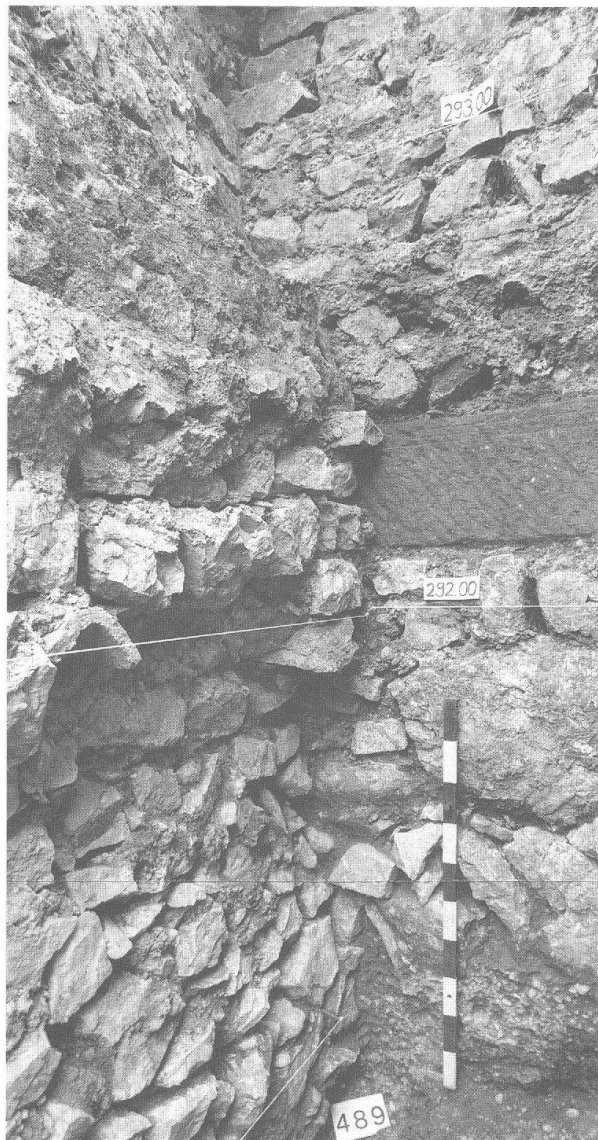
Abb. 20 Augst BL, Nordwestfront Frauenthermen, Grabung 1990.51. Ansicht an den Winkel zwischen Mauer 1 (links) und 2 von Südwesten. Bis etwa auf die Höhenlinie 292,00 m ü. M. sind beide Mauern gegen die Erde gefügt worden. Auf der linken Bildseite in der Mitte ist der obere Imbrex einer «Entwässerungsröhre» zu erkennen; auf der rechten Seite die «Sandsteinplatte», darüber der 2. Bauzustand von Mauer 2 mit der zugehörigen Fase (am oberen Bildrand).
