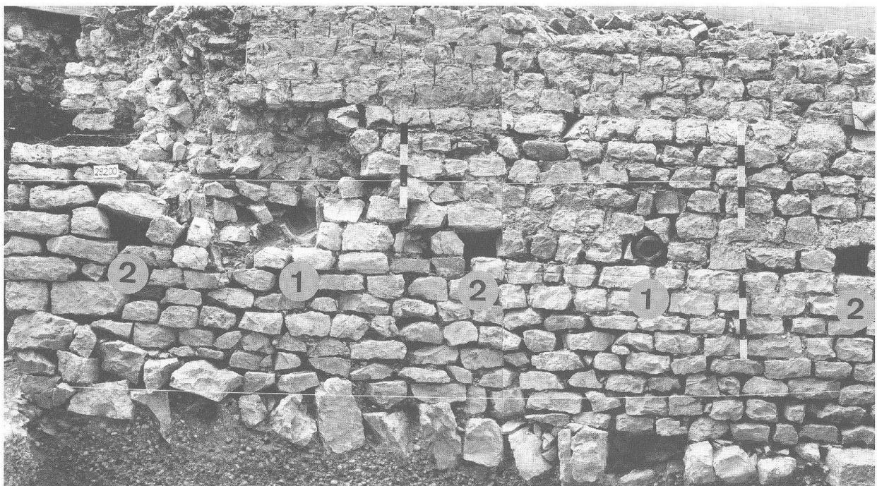
Abb. 19 Augst BL, Nordwestfront Frauentermen, Grabung 1990.51. Ansicht an die Mauer 1 von Norden (Aussenseite). Unterhalb der Höhenlinie 292,00 m ü. M. (obere Schnur) sind die Röhren aus Imbrices (1) und die Gerüstbalkenlöcher (2) zu erkennen. Drei Lagen oberhalb der Höhenlinie 292,00 m ü. M. ist die Fase des 1. Bauzustandes zu erkennen. M. 1:25.
