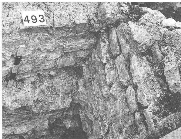
Abb. 21 Augst BL, Nordwestfront Frauenthermen, Grabung 1990.51. Blick von Süden auf die Ecke von Mauer 1 (links) und 2. Oberhalb des Absatzes auf der linken Bildseite die Reparaturstelle – wichtigster Zeuge des 2. Bauzustandes; dazu gehört auch der damit im Verband errichtete obere Teil von Mauer 2 (rechts). Vgl. Abb. 14 und 20, oben.
