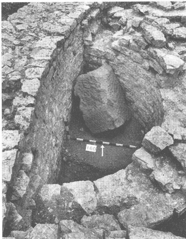
Abb. 22 Augst BL, Osttor. Grabung 1991.52. Blick gegen Norden. Der Sandsteinquader im Entlastungsbogen von Mauer 20 ist wohl vor oder während dem Auffüllen des Grabmonumentes in den Hohlraum gefallen.
