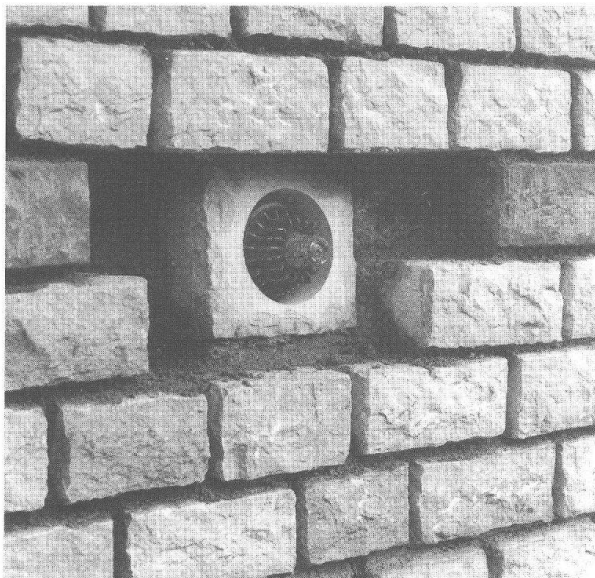
Abb. 35 Augst, Theatersanierung (Grabung 1992.55). Die Glasfaser-Maueranker mit schwarzer Kunststoff-Mutter, Kalkstein-Muffe und – noch nicht erfolgter – Handquader-Verblendung (vgl. Abb. 37; Drittes Theater, Mauer 1, Westseite).
