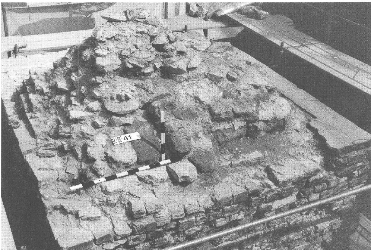
Abb. 27 Augst, Theatersanierung (Grabung 1992.55), Drittes Theater. Detail von Nordteil von Mauer 1, oberster erhaltener Bereich (Fensteröffnung im Vordergrund; Abb. 25): vorne bei den Massstäben sind die untersten Tuffsteine des Fensterbogens in situ erhalten (vgl. Abb. 4, links unten und Abb. 6).
