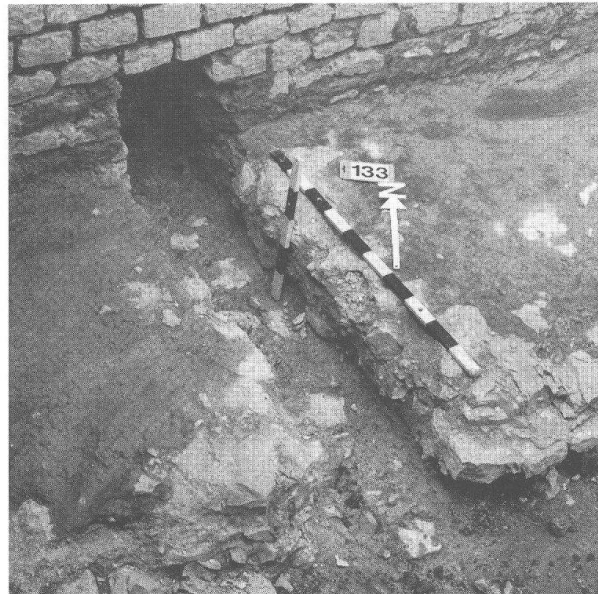
Abb. 18 Augst, Theatersanierung (Grabung 1992.55). Sondiergräbchen in Mauer 7 (Abb. 5, links) zur Abklärung allfälliger Fugen innerhalb des Mauerklotzes 3/6/7. Es zeigte sich, dass die Fläche im Vordergrund einen Abbruchhorizont darstellt, auf den später die Mauer 6 gestellt wurde (Abb. 4). Diese Abbruchfläche wies stellenweise mit auffallend vielem Sandsteinstaub vermischten Mörtel auf. Es ist anzunehmen, dass darauf Sandstein-Bodenplatten oder -schwelle des Zweiten (Arena-)Theaters lagen.
