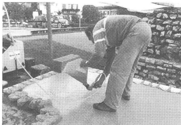
Abb. 17 Kaiseraugst, Kastellmauer Südwest-Turm. Rolf Fux beim Aufspritzen des Isoliermörtels F92 auf die vorbereitete Schicht unter der Abdeckung.
