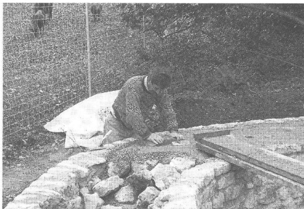
Abb. 15 Augst, Osttor (Grabung 1993.52). Aufmauern des südlichen Turmfundamentes.
