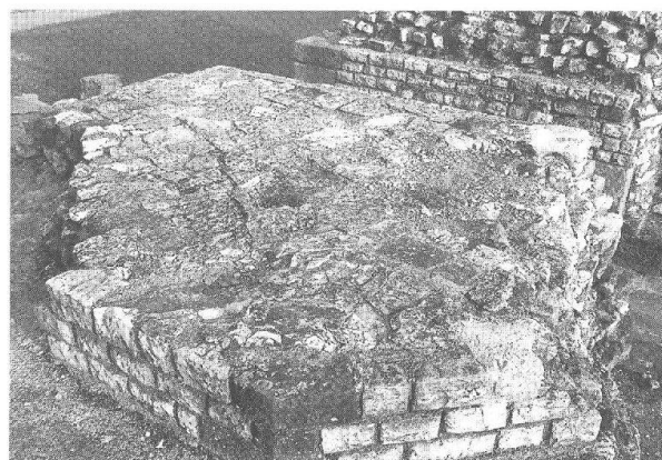
Abb. 16 Kaiseraugst, Kastellmauer Südwest-Turm. Zustand Anfang 1993.
