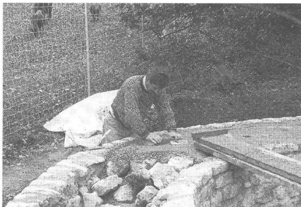
Abb. 15 Augst, Osttor (Grabung 1993.52). Aufmauern des südlichen Turmfundamentes.
