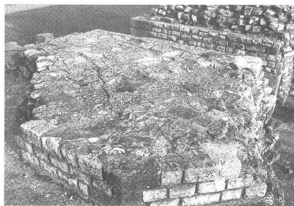
Abb. 16 Kaiseraugst, Kastellmauer Südwest-Turm. Zustand Anfang 1993.
