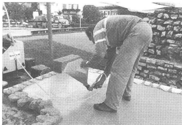
Abb. 17 Kaiseraugst, Kastellmauer Südwest-Turm. Rolf Fux beim Aufspritzen des Isoliermörtels F92 auf die vorbereitete Schicht unter der Abdeckung.
