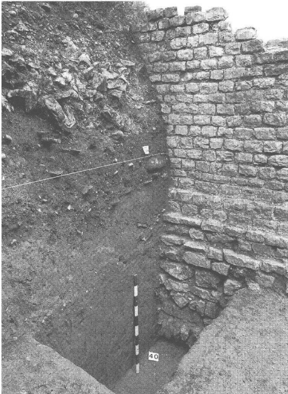
Abb. 12 Augst, Osttor (Grabung 1993.52). Links: Profil 1; rechts: Stadtmauer Nordteil (Mauer 38). Blick gegen Nordosten.
