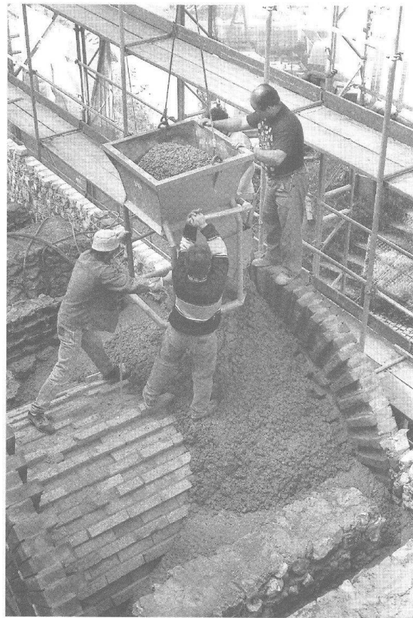
Abb. 27–28 Augst, Theatersanierung (1993). Unter dem kritischen Blick des Bauingenieurs wird der obere Teil der Gewölbeschale betoniert.
