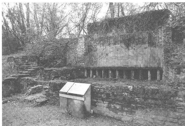
Abb. 3 Augst, Insula 10, sog. Hypokaustzimmer am «Schneckenberg» (Grabung 1995.62). Zustand der Ruine 1995 vor der Restaurierung.
