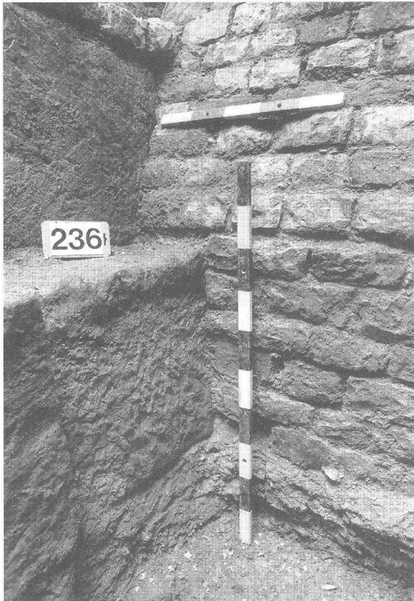
Abb. 6 Augst, Theatersanierung (Grabung 1994.55). Ansicht von Südwesten an den «Eckverband» von MR 245 und MR 1/MR 244. Erkennbar sind links die Überreste der älteren Pfeilerphase (MR 245), die ursprünglich aus mindestens zwei Lagen von Buntsandsteinquadern bestand. In der rechten Bildhälfte ist die gleichzeitig mit MR 245 entstandene Mauer 244 zu sehen, darüber die schräg verlaufende, zehn Steinlagen starke Abfasung in der Aditusmauer MR 1/MR 244.
