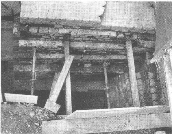
Abb. 3 Augst, Theatersanierung (Grabung 1994.55). Aufsicht auf die Grabungsfläche und den abgetreppten Stützpfiler MR 14/ MR 245/MR 250. An der Unterkante des Pfeilers ist die aus grossen Buntsandsteinquadern bestehende ältere Bauphase (MR 245) zu erkennen. Am rechten Bildrand erkennt man die schräg verlaufende Abfasung in MR 1/MR 244.
