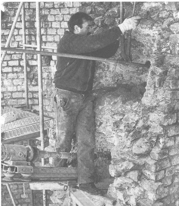
Abb. 41: Augst, Theatersanierung (Grabung 1997.55). Nördliche Cavea-Abschlussmauer (MR 60). Einfädeln eines der 7–9 m langen Erdanker in ein Bohrloch. Anschliessend wird das Bohrloch durch eine Öffnung im Zentrum der Ankerstange mit einer speziellen Zementmischung unter Druck verpresst.
