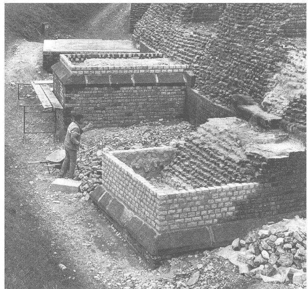
Abb. 31: Augst, Theatersanierung (Grabung 1997.55). Aufmauern der Stützpfiler nördlich der Umfassungsmauer (MR 57) in antiker Mauertechnik, also mit äusserer Schale und Kernmauerwerk aus Stampfnörten und Bruchsteinen.
