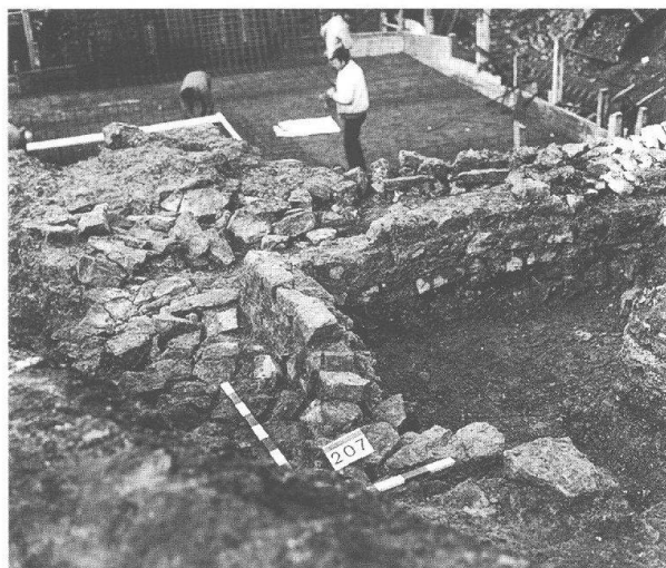
Abb. 9: Augst BL, Region 9,D (Grabung 1984.52). Blick an die im Inneren des spätromischen Turmfundamentes als Mauerschalen wiederverwendeten kaiserzeitlichen Mauer 4 (hinten) und Mauer 35 (links). Der Zwischenraum zwischen dem Gussmauerwerk 6 (im Hintergrund) und den kaiserzeitlichen Mauerzügen wurde aus Spargründen und/oder wegen Mangel an Bindemittel lediglich mit lageweise verlegten Kalkbruchsteinen verfüllt. Zur Lage vgl. Abb. 2.
