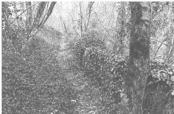
Abb. 17: Pratteln BL, Region 10 (Grabung 1997.74). Blick auf einen besser erhaltenen Abschnitt des spätmittelalterlichen Mühlekanales in der Flur Widen. Die mächtigen Sandsteinquadern der ergolzseitigen Kanalwange (rechts; vgl. auch Abb. 18) sind vollständig überwuchert. Zur Lage vgl. Abb. 15,2.
