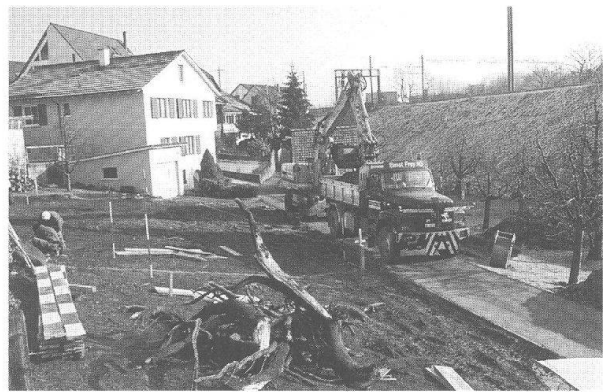
Abb. 3: Augst BL, Hausmattweg, Region 10,B (Grabung 1998.52). Der Bauplatz wird abhumusiert. Bagger und Lastwagen stehen auf dem Schlössliweg, rechts angeschnitten der Bahndamm SBB. Von Westen.
