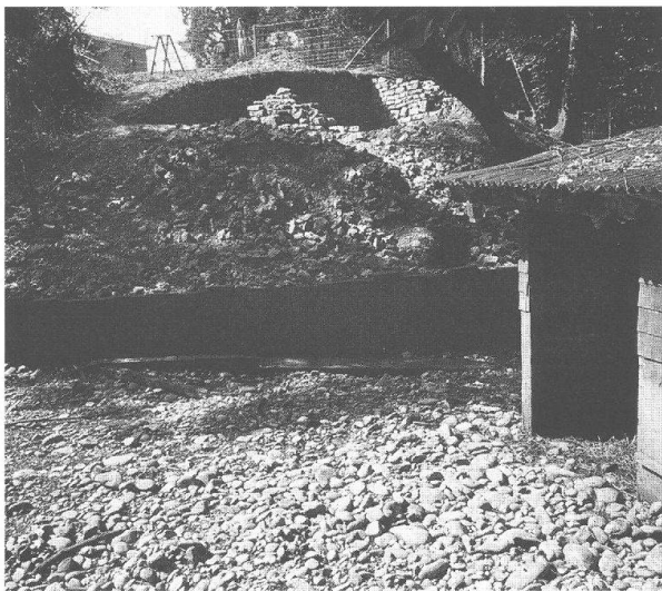
Abb. 42: Augst, Osttorareal (Grabung 1998.56). Situation der Grabung in Befundzone 6 von Nordosten. Beachte die Topographie des Geländesporns. Im Hintergrund oben das Profil mit den beiden Widerlagermauern 46 und 47. Im Vordergrund der ebenerdige Bereich der Schweinegehege. Rechts: Stallgebäude.
