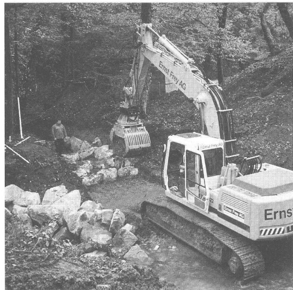
Abb. 44: Augst, Violenbach unterhalb des Osttores (Grabung 1998.56). Im Zusammenhang mit den Renaturierungsarbeiten am Violenbach wird eine Umgehungsrinne für die Fische errichtet. Blick gegen Osten.
