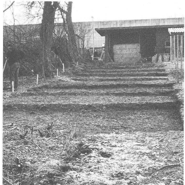
Abb. 13: Augst, Osttorareal (Grabung 1998.56). «Bauen über den Ruinen»: Ansicht der minimal terrassierten Abgrabung in Befundzone 2. Auf dieses Terrain kamen die vorfabrizierten und auf Micropfählen ruhenden Bodenplatten des Wirtschaftstraktes für die Grossesel und die Futtervorräte zu liegen (Abb. 14), ohne dass die darunter liegenden römischen Kulturschichten tangiert werden mussten. Blick gegen Südosten.
