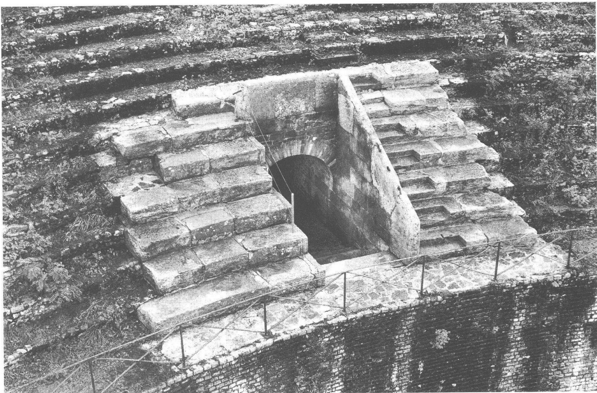
Abb. 25: Augst, Theatersanierung (Grabung 1998.55). Mündung des Südostvomitoriums in den Sitzstufenbereich. Rekonstruktion der Überwölbung von 1939/40 in Stahlbeton und mit sekundär verwendeten antiken Sandsteinquadern (Blick von Westen aus dem Krankorb).
