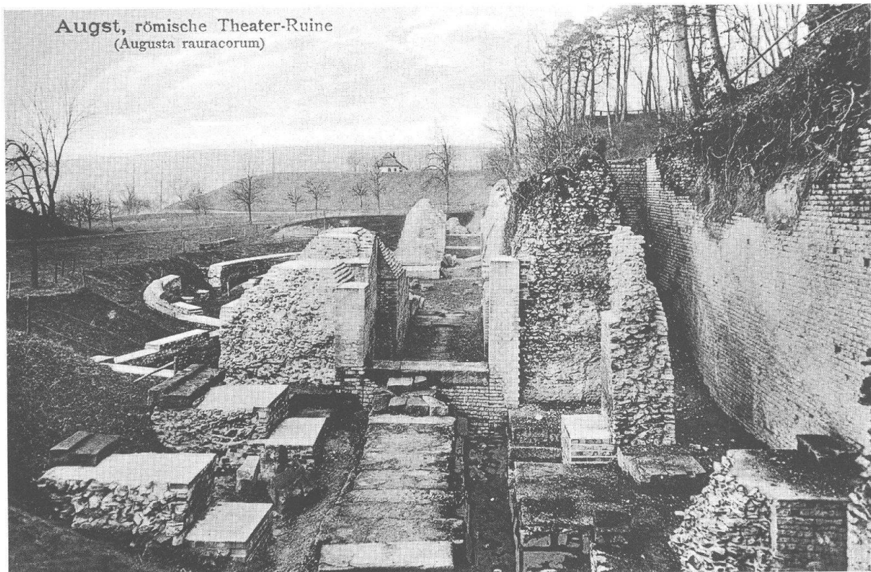
Abb. 29: Augst, Theater (um 1910). Blick von Süden in den Südaditus nach erfolgten ersten Restaurierungsarbeiten.
