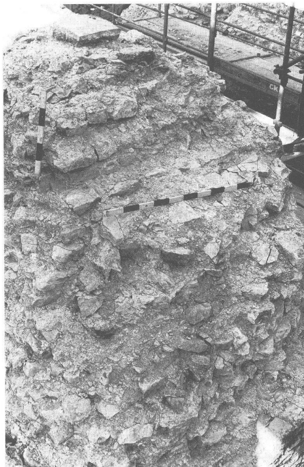
Abb. 4: Augst, Theatersanierung (Grabung 1998.55). Südaditus, westliche Bühnenmauer von Süden (MR 44). Nördliches Fenstergewände mit getreppt verlaufendem Widerlager des Fenstergewölbes. Vor dem unteren Teil der Abmauerung, wo der Massstab liegt, ist der Rest des Bettungskeiles für das Gewölbeauflager zu erkennen.
