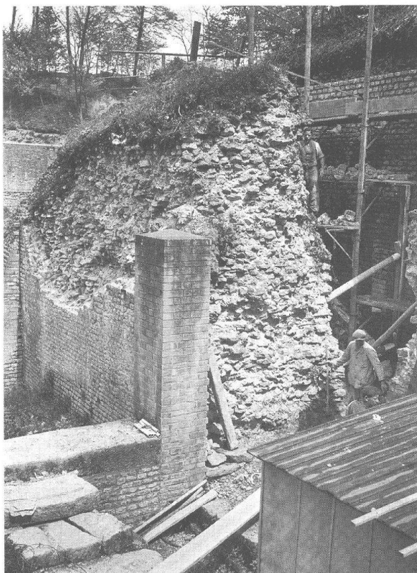
Abb. 31: Augst, Theatersanierung (Grabung 1936.59). Südaditus. Die innere Bühnenmauer (MR 43) 1936 vor den Restaurierungsarbeiten. Blick von Süden.
