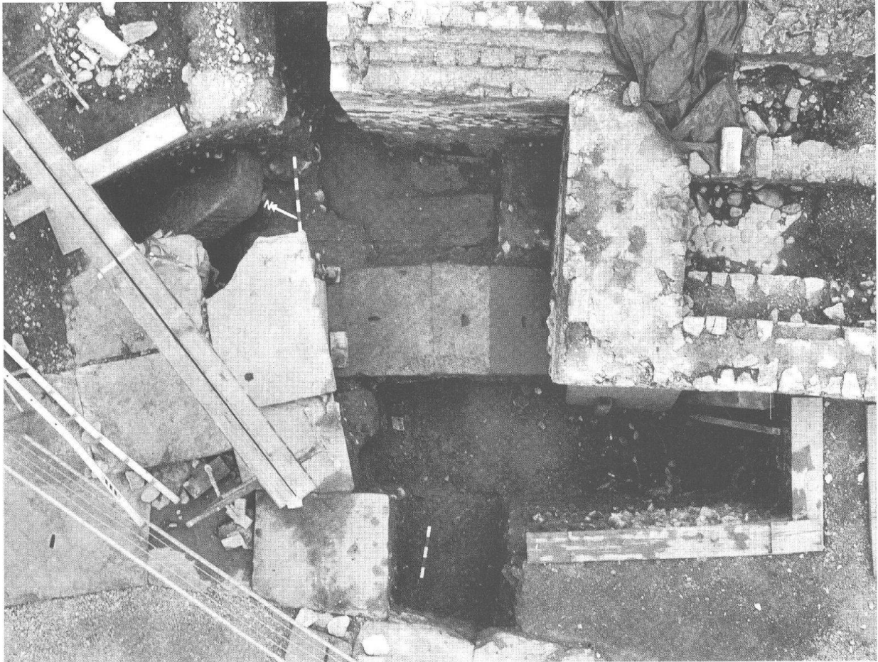
Abb. 7: Augst, Theatersanierung (Grabung 1998.55). Ostcarcer des Amphitheaters (Abb. 1,2). Übersicht über die Grabungsfläche; im Zentrum die Schwelle aus grossen Buntsandsteinquadern, links davon der Sandsteinplattenbelag der Altar- oder Statuennische des jüngeren szenischen Theaters.
