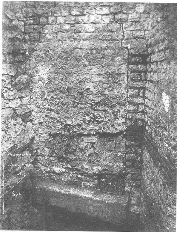
Abb. 19: Augst BL, Curia (Grabung 1907/1908.60). Ansicht der ursprünglich in das Untergeschoss der Curia führenden und später zugemauerten Türe. Von links stösst Mauer U direkt an die zugemauerte Türöffnung; rechts befindet sich der Stützpfeiler Nr. 2 (vgl. Abb. 16). Am unteren Bildrand ist die Schwelle aus Kalkstein zu erkennen.
