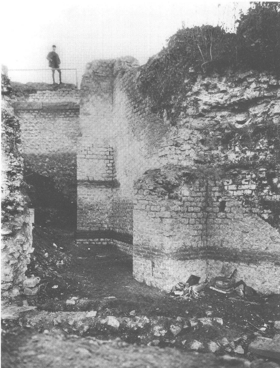
Abb. 15: Augst BL, Curia (Grabung 1907/1908.60). Ansicht von Osten an die Curia mit den beiden Stützpfeilern 2 und 3. Im Vordergrund ist noch die Krone von Mauer U/Mauer 1 zu erkennen. Unterhalb der stehenden Person im Hintergrund befindet sich die mit Buntsandsteinquademern abgedeckte Mauer E (vgl. Abb. 16).
