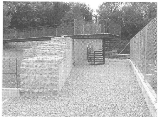
Abb. 39: Augst, Violenried, ehemaliges E. Frey-Areal (Grabung 2000.60, Konservierung 2000.925). Teilrekonstruktion der nördlichen Hangstützmauer mit Wendeltreppe. Der Zaun rechts steht auf einer neuen hohen Betonstützmauer, die das Gelände bis zur Sohle der ehemaligen Kastelen-Kiesgrube (rechts und hinten) abfängt.
