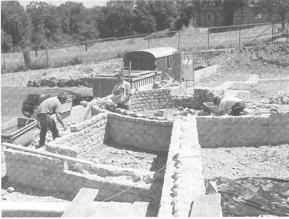
Abb. 41: Augst, Violenried, ehemaliges E. Frey-Areal (Grabung 2000.60, Konservierung 2000.925). Maurerarbeiten an der Badeanlage.
