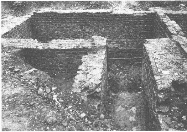
Abb. 24: Kaiseraugst AG, EFH Wettstein (Grabung 2000.12), Blick von NE in den ausgeräumten Keller 2 (Abb. 22,K 2).
