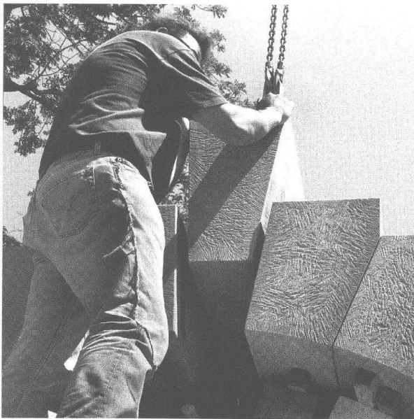
Abb. 25: Augst, Theatersanierung (Grabung 2000.55). Rekonstruktion des Werksteinbogens am Mündungsbereich des Südost-Vomitoriums. Der Schlussstein wird vorsichtig in die Lücke am Scheitelpunkt des Bogens eingeschoben.
