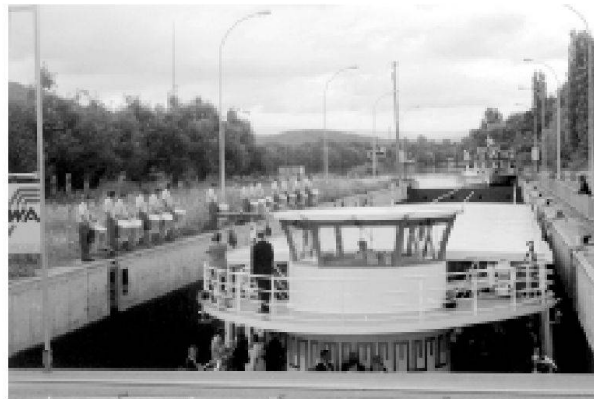
Abb. 1: Die grosse Festgesellschaft am Heinrichstag mit den Gästen der Kantonsregierungen beider Basel hat die Römerstadt zu Fuss verlassen, zwei Rheinschiffe bestiegen und macht sich in der Augster Schleuse auf zu einer Lunchfahrt flussabwärts Richtung Basel. Von der Römerstiftung auf Kastelen in Augst über den Fussweg entlang der Ergolz zu den Schiffen sowie während der ganzen zweistündigen Fahrt auf dem Rhein war die Jubiläumsgesellschaft von verschiedenen Musikformationen zu Wasser und zu Lande begleitet (im Bild links: Tambouren aus dem Regimentsspiel beider Basel).
