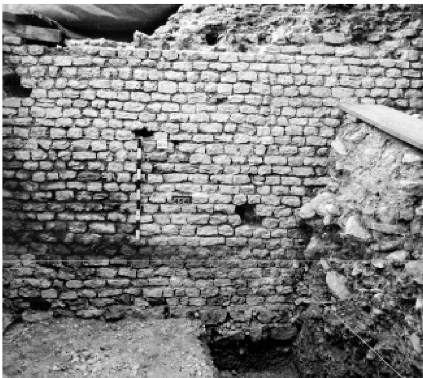
◀ Abb. 19: Augst BL, Kunz-Suter (Grabung 2001.51). Mauer MR 7, Aufgehendes und Fundament der Innenseite = Südseite. Das dunkel verfärbte Band markiert die Höhe des Gehniveaus im Raum innerhalb der Mauern. Die Lücken in der Mauer- schale rühren von herausgefallenen Stei- nen her und sind rein zufällig. Von Süden.
