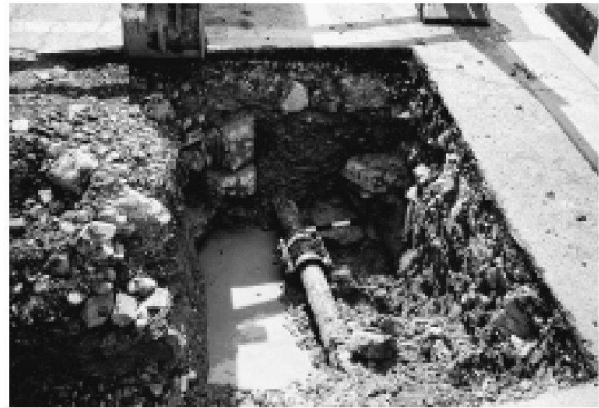
Abb. 31: Augst BL, Region 10,B (Grabung 2001.57). Dieses Jahr in Augst ein häufiges Bild! – Wasserleitung mit Reparaturmuffe, hier in der Poststrasse. An der Schmalkante des Grabens, über dem Wasser, die von Süden herankommende Innenunterteilung, rechts die West-Ost verlaufende Aussenmauer eines neuzeitlichen Gebäudes, das bei der Erweiterung der Poststrasse abgebrochen worden war. Von Norden.
