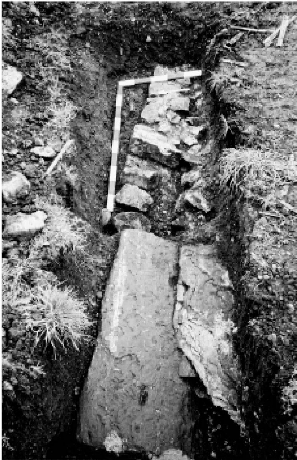
Abb. 26: Augst BL, Nordwestzugang Oberstadt (Grabungen 2001.52, 2001.53, 2001.54 und 2001.67). Portikusmauer an der Nordseite der Rauricastrasse im nordöstlichsten Teil des Kabelgrabens Schulweglein (2001.52). Die Strassenfläche wäre auf diesem Bild rechts, die Portikusfläche links. Vor ein grosser Sandsteinquader als Basis für eine Säule der Portikusbedachung; er ist seitlich vom gemauerten Fundament hinunter verkippt. Von Westen.
