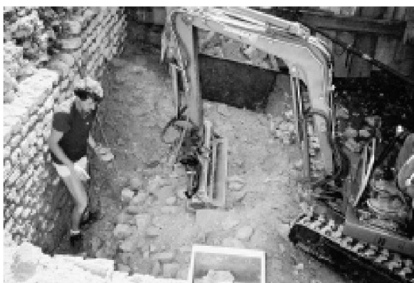
Abb. 13: Augst BL, Kunz-Suter (Grabung 2001.51). Abbau des mächtigen Mauerversturzes innerhalb der Mauern MR 7/MR 6 mit Hilfe des Kleinbag-gers.
