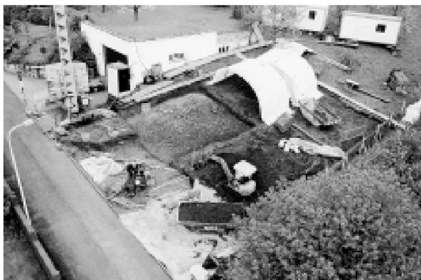
Abb. 5: Augst BL, Kunz-Suter (Grabung 2001.51). Aufnahme während der Ausgrabungsarbeiten. Links die Sichelstrasse. Das Bild zeigt die beengten Verhältnisse, unter denen diese Ausgrabung abgewickelt werden musste. Von oben und Südwesten.
