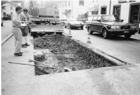
Abb. 51: Augst BL, Belagserneuerung Hauptstrasse (Grabung 2001.66). Ungemütliche Arbeitsstelle neben dem Bagger und in einer der am dichtesten befahrenen Dorfstrassen der Schweiz. Aushub in der nördlichen Fahrspur der Strasse. Von Westen.
