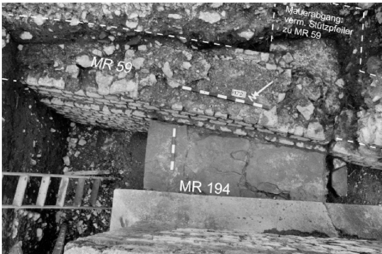
Abb. 28: Augst, Theatersanierung (Grabung 2001.55). Umfassung jüngeres szenisches Theater, Stützpfiler MR 194/Umfassung älteres szenisches Theater MR 59. Aufsicht auf den Mauerbefund in den Feldern 170 und 172 von Nordwesten.
