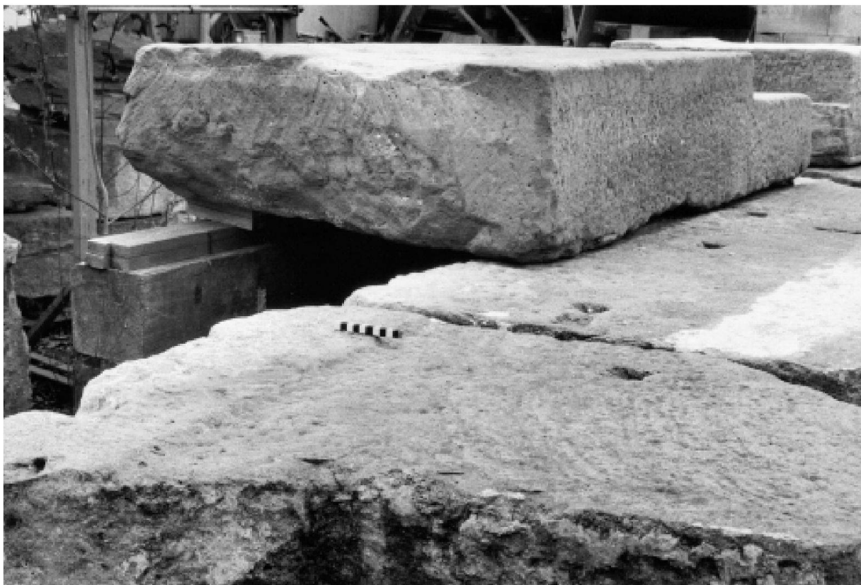
Abb. 4: Augst, Theatersanierung (Grabung 2001.55). Architekturprobe unter Verwendung von originalen Sitzstufenquadern des jüngeren szenischen Theaters. Oben ein grosser Stufenquader mit ausgehauenen Treppentritt (am rechten Bildrand), fein gespitzter Stirnseite und Seitenfläche mit dreiseitiger Anathyrose. Unten Oberflächen von zwei Sitzstufenquadern mit Glättung als Auflager für die nächsthöhere Sitzstufenreihe und davor liegenden Stemmlöchern.
