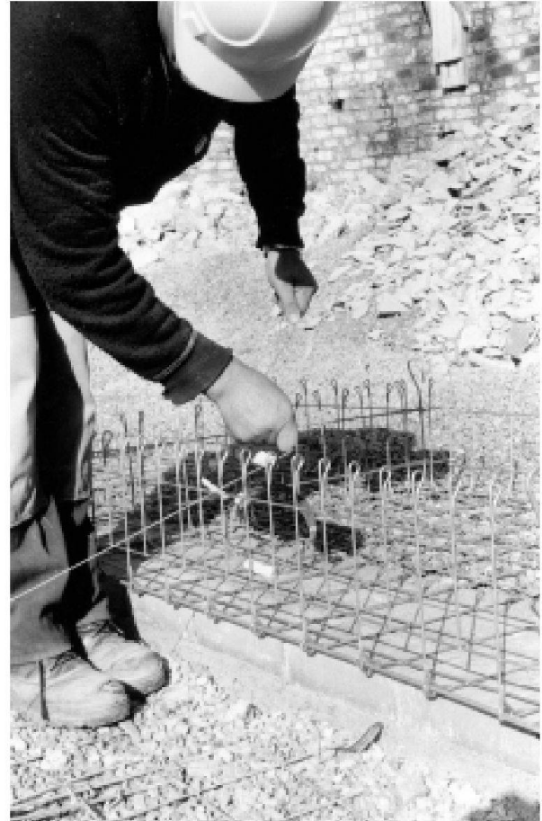
Abb. 18: Augst, Theatersanierung (Grabung 2001.55). Moderne Sitzstufenrekonstruktion. Einrichten und Kontrollieren der Gitterkörbe mit Hilfe eines gespannten Drahtseils. Gut erkennbar ist, wie die Körbe ca. 5 cm über das Ringfundament aus Zementsteinen und Beton vorkragen.
