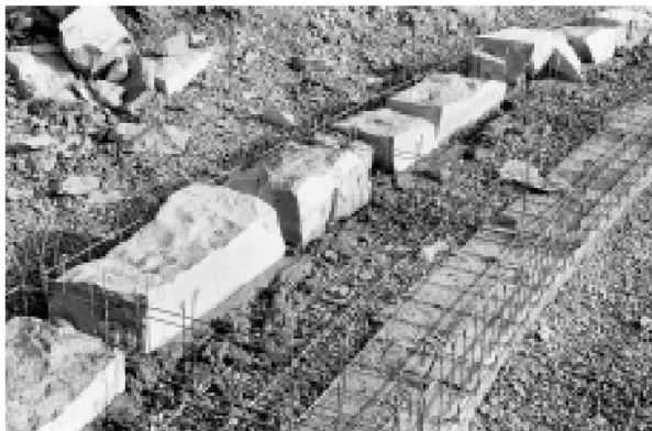
Abb. 20: Augst, Theatersanierung (Grabung 2001.55). Moderne Sitzstufenrekonstruktion. Einbringen von Fräsabschnitten aus Kalkstein zur Fixierung der fertig versetzten Gitterkörbe.
