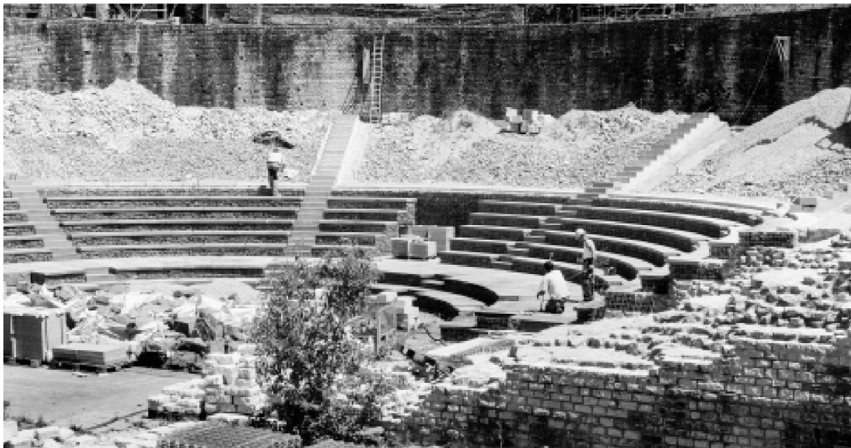
Abb. 26: Augst, Theatersanierung (Grabung 2001.55). Moderne Sitzstufenrekonstruktion. Blick von Südwesten auf das fertiggestellte unterste Drittel mit der nachgewiesenen Nische im Zentrum (vgl. Abb. 13). Die Fernwirkung lässt die Gitterkörbe zurücktreten und gibt Raum für eine Licht- und Schattenwirkung, die den Horizontalverlauf der Sitzstufenreihen unterstreicht. Im Bereich der Auffüllung sind die Betonfundamente für die Treppenläufe deutlich erkennbar.
