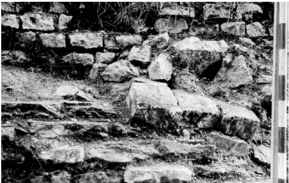
Abb. 10: Augst, Theater. Südost-Vomitorium, Südwanne mit ansteigendem Gewölbeauflager des Tuffsteingewölbes, Detail zu Abb. 11, Zustand nach der Freilegung 1939. Reste von drei Tuffkeilsteinen der Anfängerreihe in situ. Die plattigen Kalksteine des Kämpfers sind grösstenteils weggebrochen. Im Hintergrund das Haupt der Widerlagermauer. Die Kalkbruchsteine zwischen dem Widerlager und den Tuffkeilen gehören zur Kalksteinfüllung, die zur Verstärkung der Auflast über den Bogenschenkeln eingebracht worden ist.
