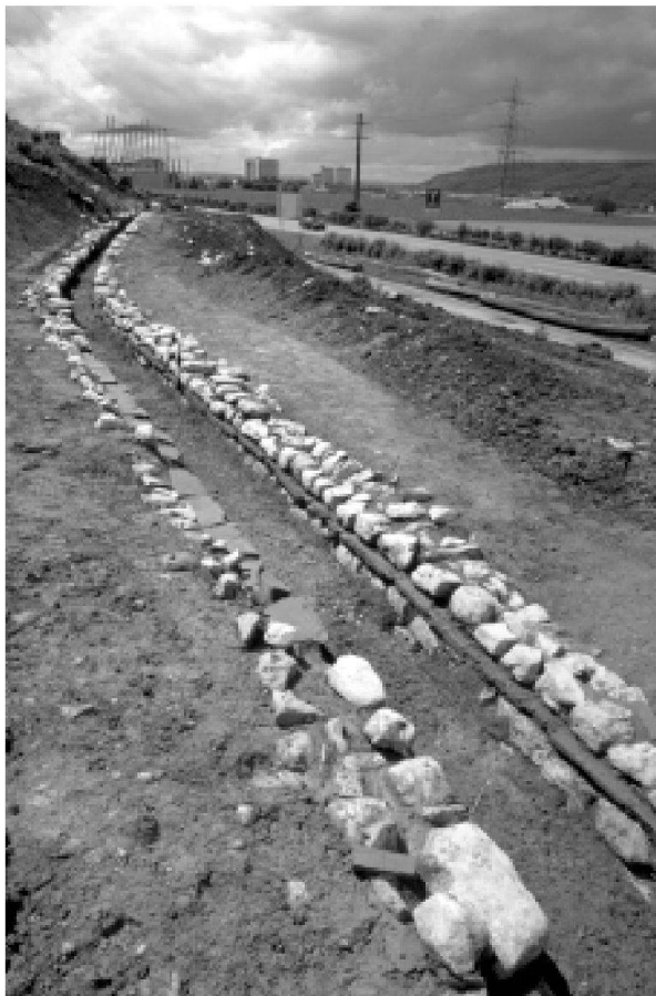
Abb. 5: Kaiseraugst-Hardhof AG. Aufsicht: der obere Kanal.
