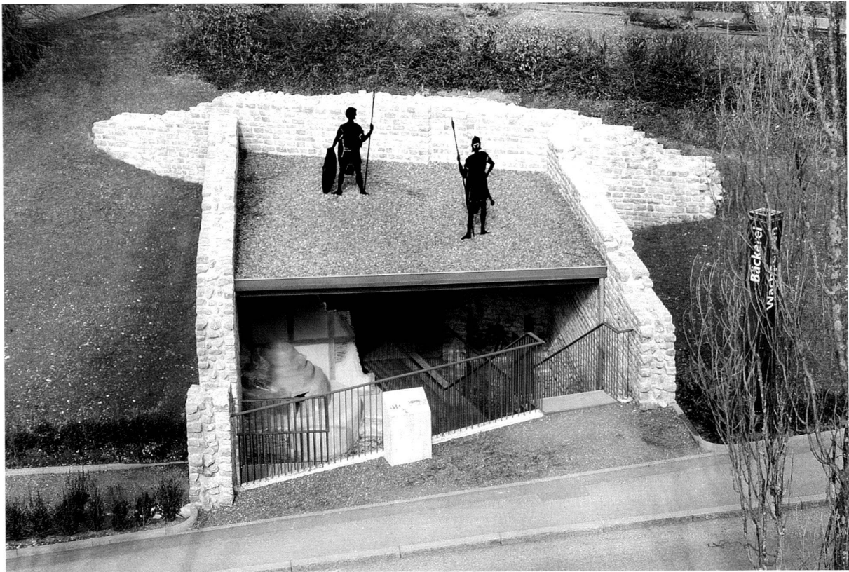
Abb. 46: Augst, Gebäude zwischen der Insula 9 und dem Theater. Neu konserviert, umgestaltet und mit neuem Schutzdach präsentiert sich die «Bäckerei» mit dem «Wachposten» im Obergeschoss nach Abschluss der Sanierungsarbeiten (2002.907).
