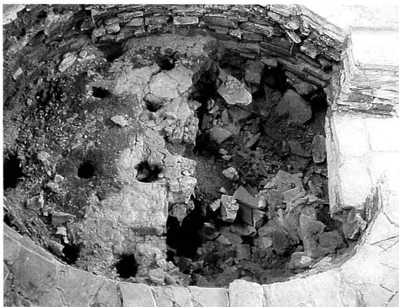
Abb. 50: Augst-Venusstrasse, Töpferei (2002.908). Ofen II ist in einem sehr schlechten Zustand, die antiken Ziegel sind vollständig durchweicht, Moos und Algen machen sich breit, die Hälfte der einst perfekt erhaltenen Lochtenne ist in den letzten Jahren eingestürzt.
