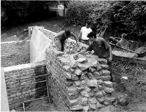
Abb. 40: Augst, Gebäude zwischen der Insula 9 und dem Theater. Konservierung «Bäckerei» und «Wachposten» (2002.907). Bruno Miguel Silva Neves, Avelino de Matos Cruz und Marco Paulo Cruz Ferreira beim Hochziehen der rückwärtigen Hangstützmauer 1.
