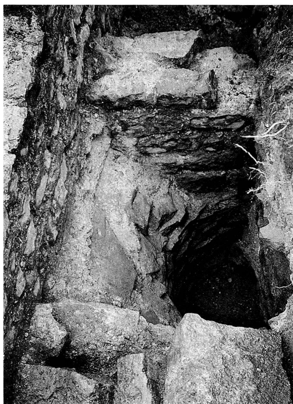
Abb. 7: Augst BL, Kastelen-Bassin (Grabung 2002.51). Aufnahme von Osten in den Schacht. Links ist die ins Innere des Schachts geneigte Konstruktion zu erkennen. Im Hintergrund am Profil ein aus Hohlziegeln konstruierter Durchlass in der Mauer.
