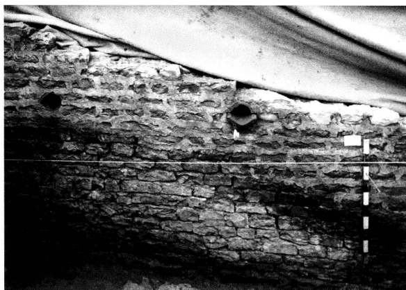
Abb. 33: Augst BL, Degen-Messerli (Grabung 2001–2002.64). Hangseite von Mauer MR 45 (zur Lage vgl. Abb. 29), der untersten Terrassierungsmauer. Im unteren Teil ist die Mauer gegen das Terrain gemauert, ab dem zur Bauzeit aktuellen Terrain frei hochgeführt und mit Fugenputz versehen worden. Knapp unterhalb der erhaltenen Krone zwei Wasserdurchlässe, die aus insgesamt je vier imbrices konstruiert waren. Diese Mauer gehört zu den am saubersten gebauten Konstruktionen innerhalb des Grabungsareals. Von Norden.
