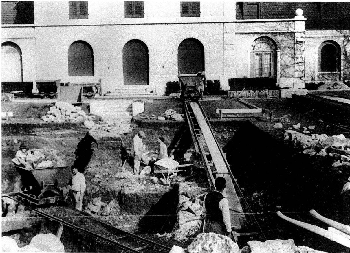
Abb. 2: Augst BL, Kastelen-Bassin (Grabung 1930.52). Aufnahme aus dem Jahr 1930 während der Vergrößerung des Schwimmbeckens.
