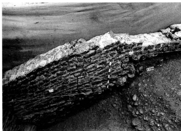
Abb. 32: Augst BL, Degen-Messerli (Grabung 2001–2002.64). Nordwand von Raum [9] (zur Lage vgl. Abb. 29). An dieser Mauer ist die Aufmauerung mittels extrem schräger Lagen von Bausteinen besonders eindrücklich. Links unten ist die Mauer in die dunkle Abfalldéponie der Holzbau-Phase(n) am Hangfuss fundaméntiert. Von Süden.
