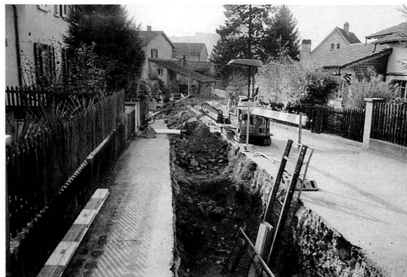
Abb. 11: Augst BL, Thermenstrasse (Grabung 2002.54). Blick nach Westen in den teilweise ausgehobenen Leitungsgraben.
