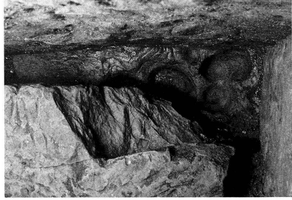
Abb. 32: Augst, Theatersanierung (Grabung 2002.55). Abwasserkanal, Verzweigung im Süden, südöstlicher Abschnitt mit Sandsteinkammer. Aufsicht auf die Südostecke des Kammerbodens mit dem älteren Sandsteinboden, in dem sich durch Wasserwirbel und darin drehende Steinchen kleine Kuhlen gebildet haben. Die Kuhlen werden teilweise durch die in der Umbauphase eingebrachte Sandsteinplatte (in der linken Bildhälfte sichtbar) verdeckt.
