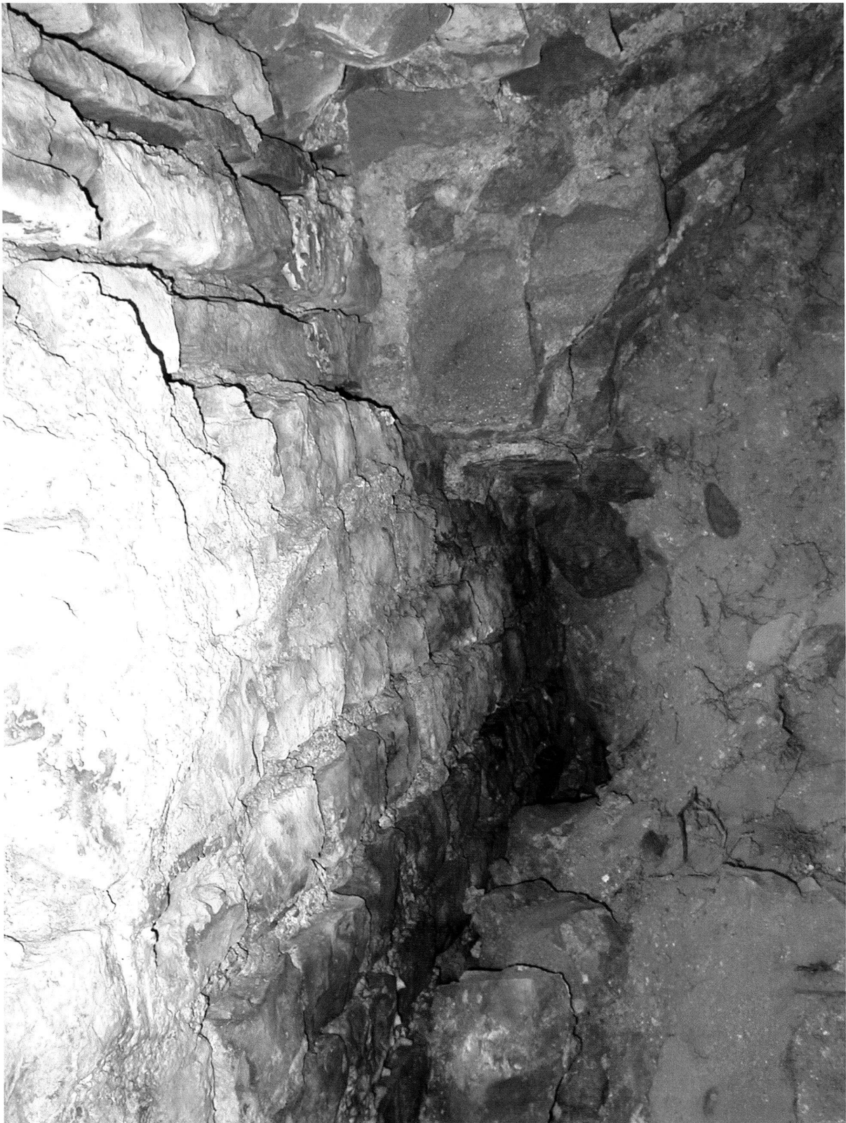
Abb. 7: Augst, Theatersanierung (Grabung 2002.55). Blendbogen der südlichen Eingangshalle. Die Abbildung gibt die Lage des Blendbogens in seinem ursprünglichen baulichen Zusammenhang wieder. Deutlich erkennbar ist die bogenförmig verlaufende Mörtelbraue am Übergang von der Nischenrückwand zur inneren Leibung des Buntsandsteinbogens. Im Zentrum der Verputzrest mit der aufgemalten Sandsteinquaderimitation (vgl. Abb. 8). Korrespondierend mit dem Scheitel der Innenleibung des Bogens ist ein 8–10 cm starker Rücksprung im opus vittatum-Mauerwerk der Nischenrückwand erkennbar. Die Quaderlagen über dem Rücksprung weisen eine geringere Stärke und einen deutlich höheren Anteil an Buntsandsteinquädrchen auf als die auf Sicht gemauerte, mit rot bemaltem Fugenstrich versehene Schale unterhalb des Rücksprungs.
