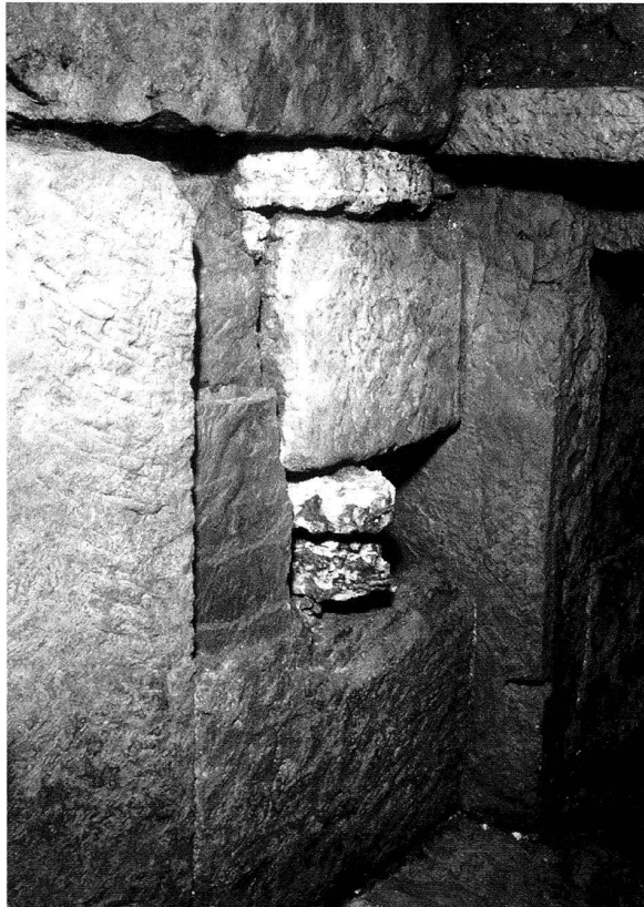
Abb. 28: Augst, Theatersanierung (Grabung 2002.55). Abwasserkanal, Verzweigung im Süden, südöstlicher Abschnitt mit Sandsteinkammer. Blick von Osten in die Sandsteinkammer. Rechts die türartige Konstruktion mit Einarbeitungen zum Anbringen eines mutmasslichen Eisengitters. Links die Mündung des vom Südforum her kommenden, südwestlichen Seitenkanals, der in Zusammenhang mit Umbaumaassnahmen an der Sandsteinkammer angelegt wurde.
