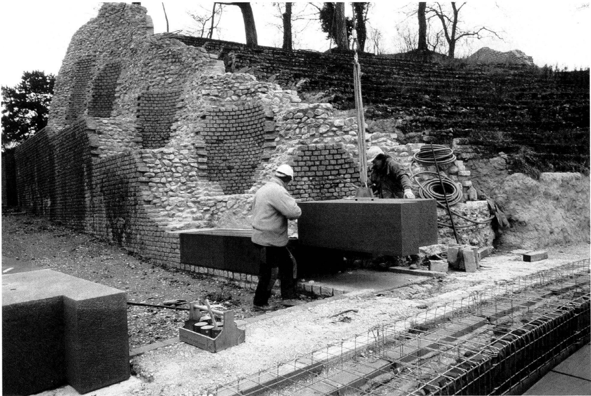
Abb. 39: Augst, Theatersanierung (Grabung 2002.55). Sanierungsarbeiten am Mittelvomitorium. Versetzen der Sandsteinquader im Mündungsbereich zur cavea unter Einsatz eines modernen «Wolfs» als Hebevorrichtung.
