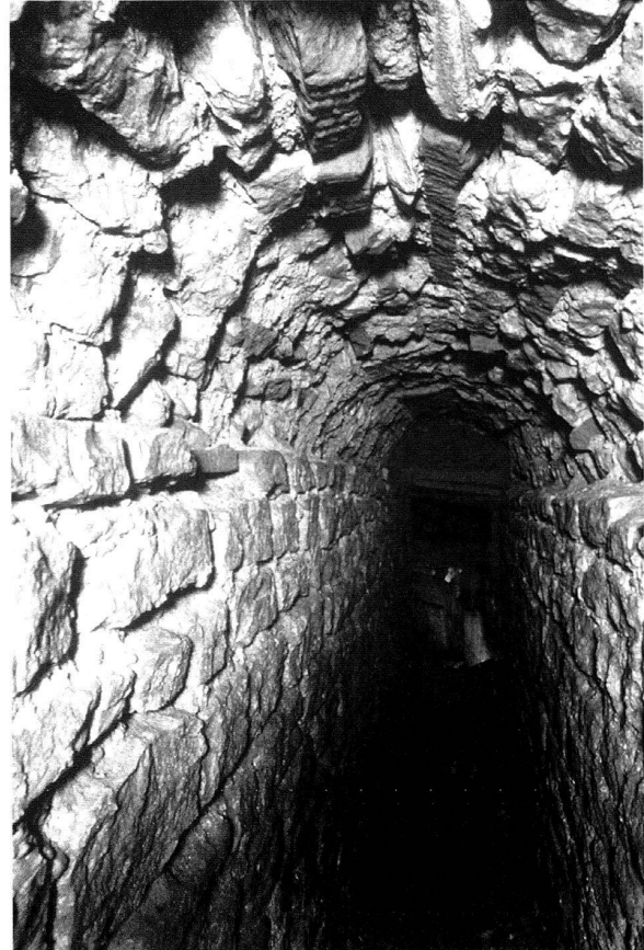
Abb. 25: Augst, Theatersanierung (Grabung 2002.55). Abwasserkanal, Verzweigung im Süden, südöstlicher Abschnitt mit Sandsteinkammer. Blick von Südosten in den südöstlichen Fortsetzungskanal mit Wänden aus opus vittatum-Mauerwerk und über Schalung errichtetem Kalksteingewölbe (vgl. auch Detail Abb. 26).
