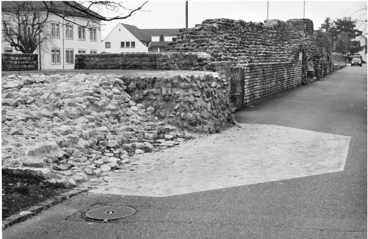
Abb. 57: Kaiseraugst Kastell-Südwestturm (Monumentensanierung 915.2003). Die Kastellmauer verläuft direkt entlang des Heidemurwegs. Im Teerbelag konnten wir 2003 mit Erlaubnis der Gemeinde den polygonalen Grundriss des Südwestturms 1 mit denselben Kalkbruchsteinen wie das aufgehende Mauerwerk – bodeneben! – markieren (im Bildvordergrund rechts). Die Markierungen der Türme 2–4 werden voraussichtlich 2005 folgen.
