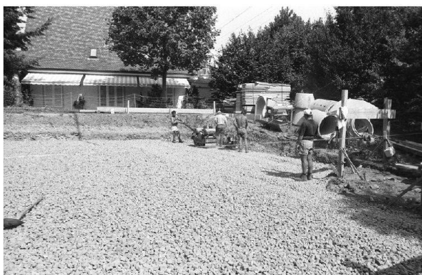
Abb. 40: Kaiseraugst AG, EFH Hockenjos, Äussere Reben (2003.05). Blick von Südwesten während des Verdichtens der Isolationschicht.
