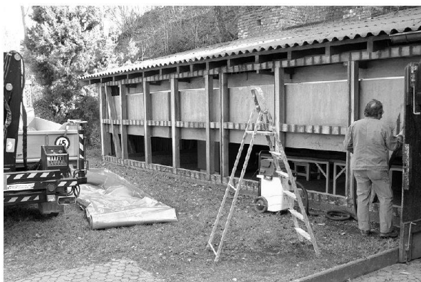
Abb. 60: Augst, Augusta Raurica, didaktische «Brotbackstube» zwischen Schönbühl und Römermuseum. Der Technische Dienst ersetzte die hölzerne Aussenwand des 1980 errichteten Schuppens, in dem jährlich rund 200 Schulklassen auf zwei originalen Steinmühlen Korn mahlen und in einem nachgebauten «römischen» Backofen die geformten Brotlaibe im Holzfeuer ausbacken.
