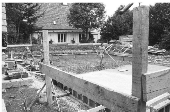
Abb. 41: Kaiseraugst AG, EFH Hockenjos, Äussere Reben (2003.05). Blick von Westen während des Betonierens der Bodenplatte.
